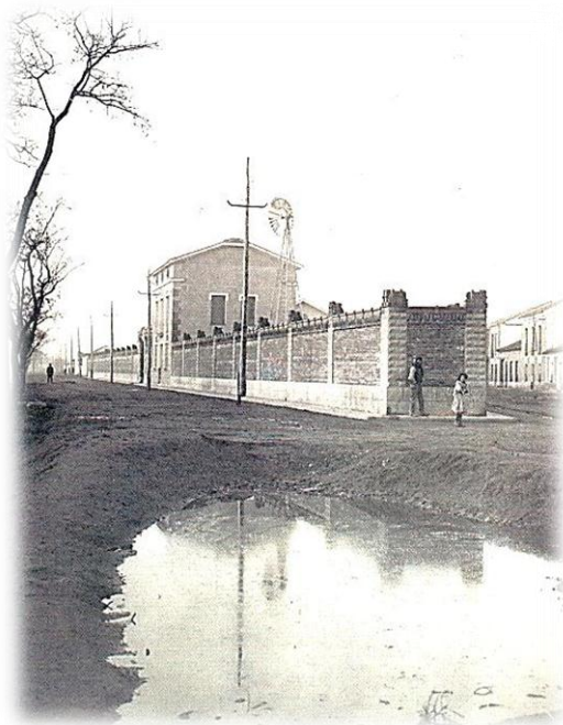
(3) Transporte eléctrico a las afueras de Valladolid. Postes con perfiles de hierro que sustenta redes protectoras.
