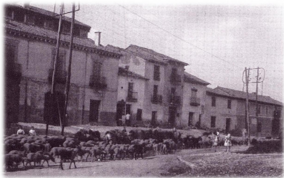
(14) Línea de transporte desde El Porvenir a Valladolid a su paso por Tordesillas. De un enorme valor informativo, se pueden apreciar, mirando bien, buenos detalles y cotejarles con las indicaciones vertidas en este proyecto; entre otros, no parece que los postes tengan una buena verticalidad, y tampoco se aprecian las redes protectoras. Foto localizada en el libro: "Tordesillas a pie de calle" del Grupo Fotográfico de Tordesillas "Ayer y hoy".
