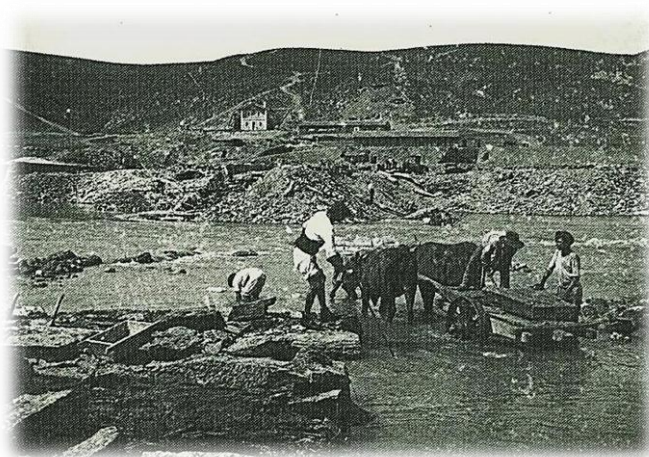
(2) Trabajos...muy duros...de construcción de la presa. Foto: D. Federico Cantero Villamil. Año 1898. En Federico Cantero Villamil: crónica de una voluntad. El hombre, el inventor de SUAREZ CABALLERO , Francisco
