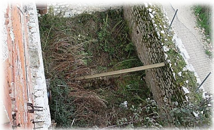
(18) Estado actual de las canalizaciones de aguas en la antigua central Huerta del Rey. Se aprecia un arco abovedado entre la maleza.
