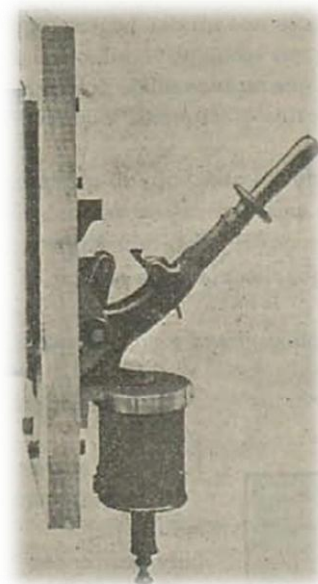
(28) Interruptor tripolar en aceite. Modelo Alioth ubicado en El Porvenir. La imagen de la izquierda está tomada de CORTEZ, Alberto, con modificaciones personales. La imagen de la derecha está tomada de La Energía Eléctrica. En la foto de la central (ver la introducción) se puede observar la disposición de los interruptores en el cuadro de maniobra y control.
