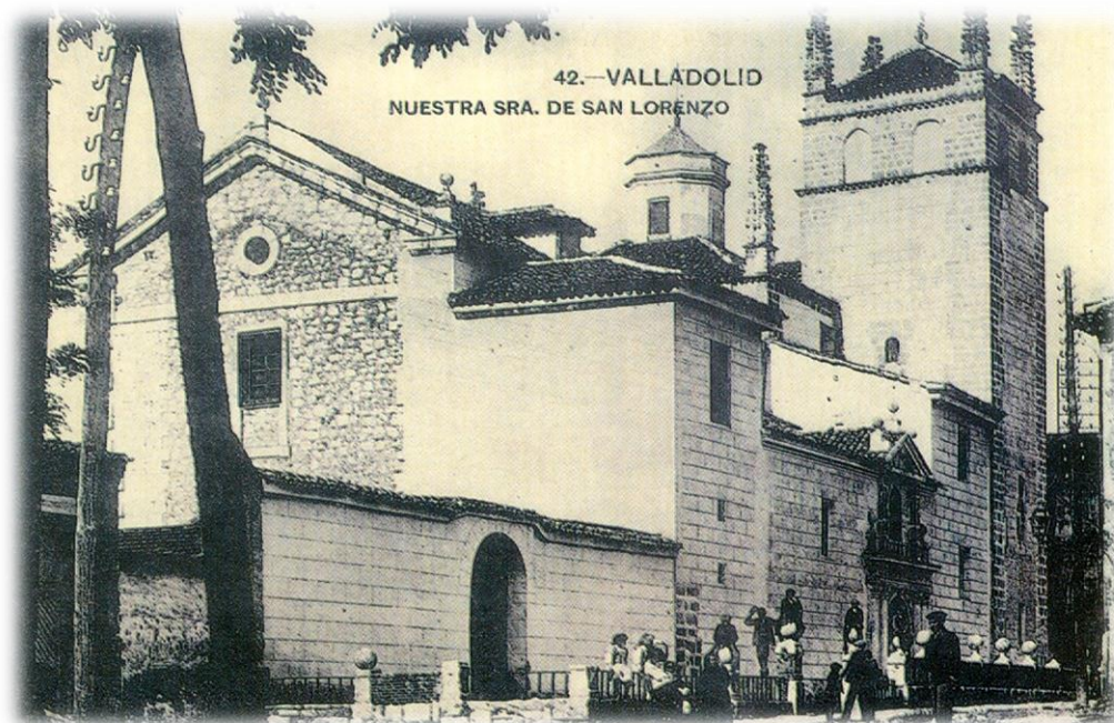
(20) Obsérvese tanto a la derecha como a la izquierda de la fotografía, sendos postes de madera con multitud de aisladores que sustentaban los conductores, que pudieran ser telegráficos. El poste de la izquierda... ¿estará así debido al peso de los cables?
