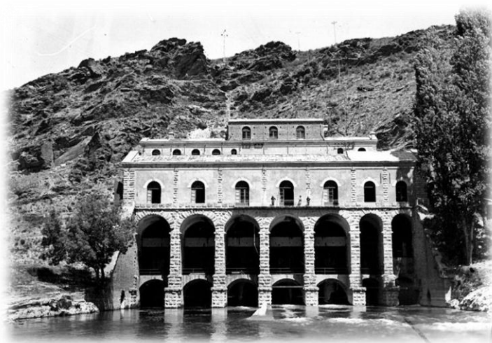
(6) En primera instancia se ven las 7 galerías. Encima se aprecian tres obreros en la balaustrada exterior de la Sala de Máquinas. AMVA Sig.: Caja 749-3
