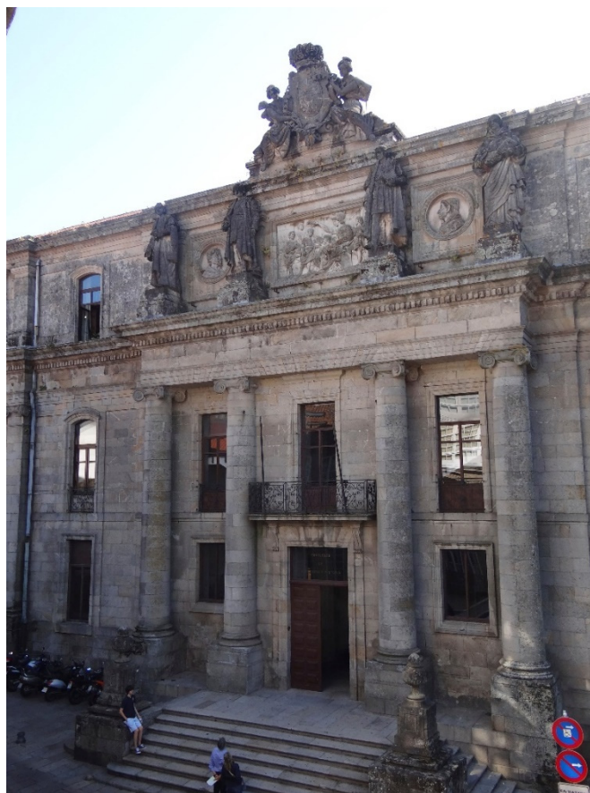
Vista general de la fachada de la USC, hoy Facultad de Humanidades.
