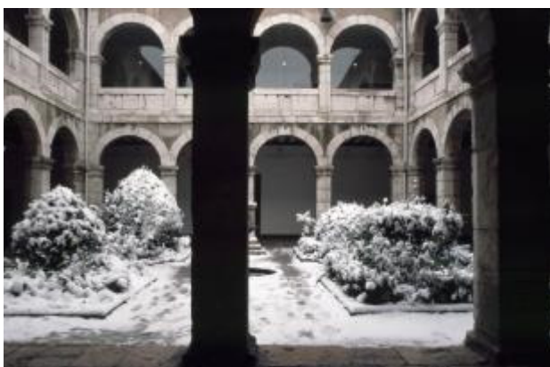
Aspectos del patio de la antigua Escuela Industrial y de Artes, actualmente con arquerías despejadas y espacio ajardinado como Colegio Mayor
