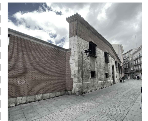
MURO PREEXISTENTE DE PALACIO
