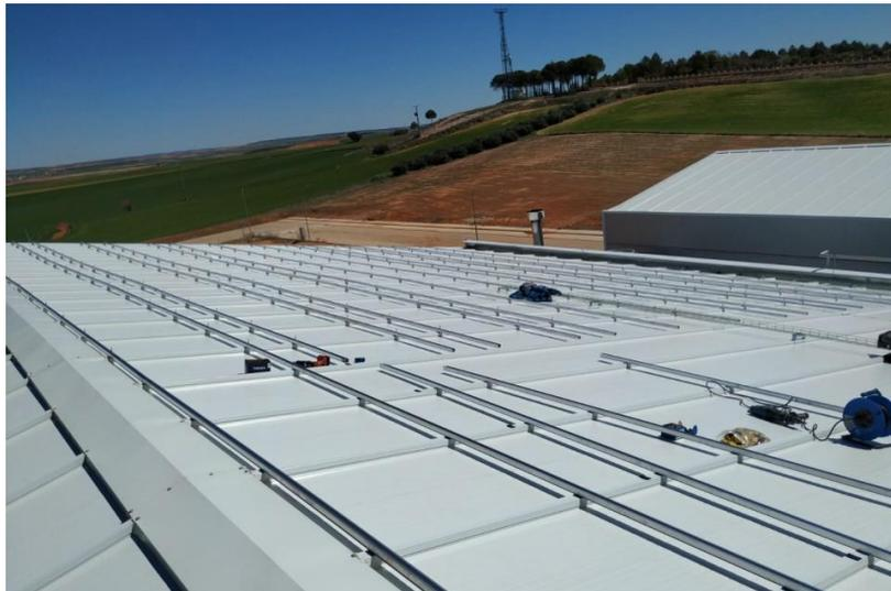
Ilustración 30: Estructura Soportante [61]
