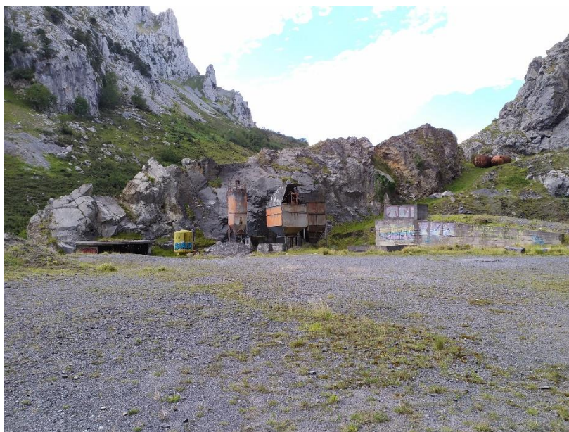
Figura 6.1.: Instalaciones abandonadas en la Zona 1"Atxarte" Fuente: Elaboración propia
