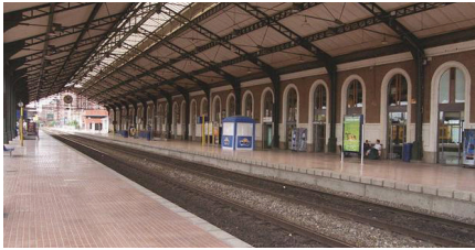
F81. Estado actual de la Estación del Norte -Valladolid Campo Grande.
