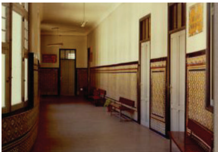
F83. Imagen antigua de la Facultad de Comercio de la Universidad de Valladolid. En esta ubicación actualmente está el Registro de la Propiedad de Valladolid.
