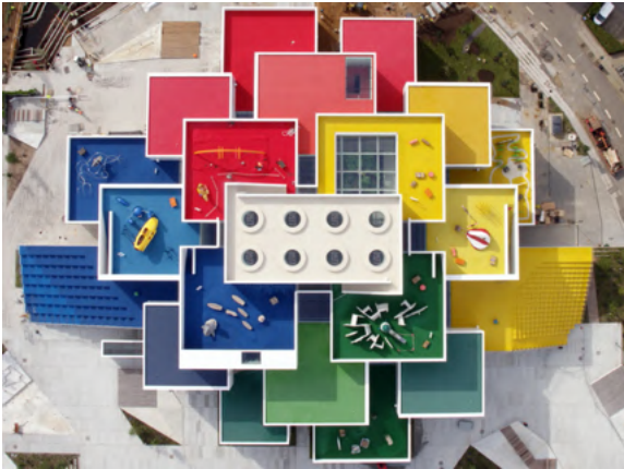
Fig. 134. Vista de la cubierta Casa Lego, BIG (2017)
