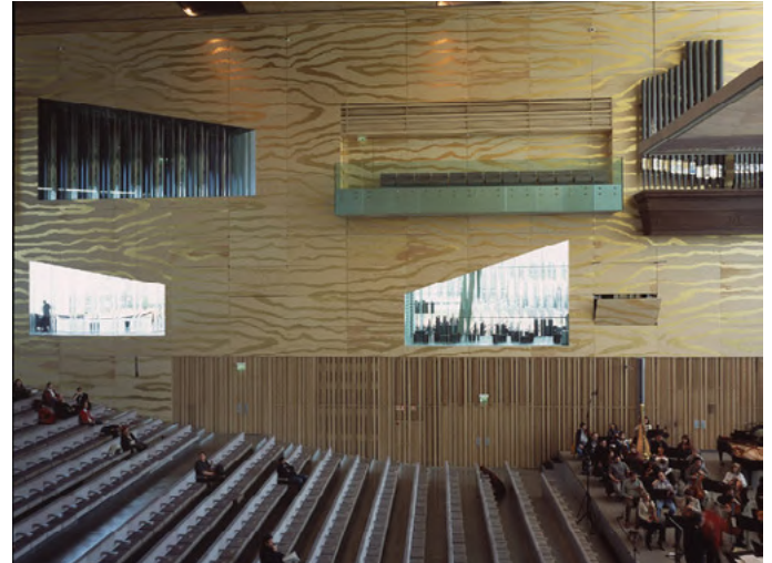
Fig. 128. Pan de oro en el interior del auditorio en Casa Da Música.
