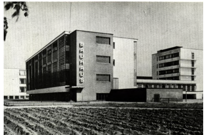
Fig. 47. Edificio de la Bauhaus en Dessau, Walter Gropius (1925).W
