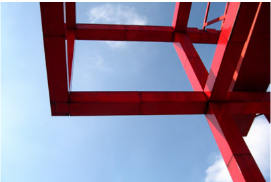
Fig. 118. Detalle Folie en el Parc de la Villette.
