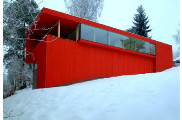
Fig. 150. Exterior Casa Roja, JVA (2002).
