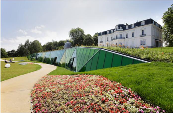
Fig. 137. Exterior Centro Cultural y Palacio Aiete.
