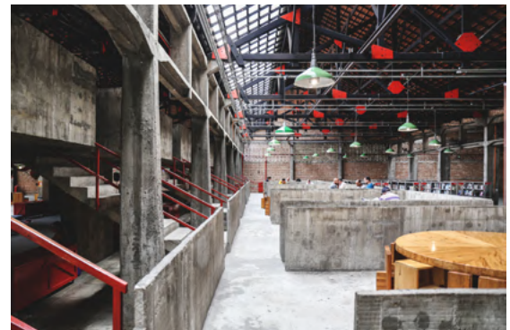
Fig. 154. Interior SESC Pompeia con cerchas destacadas.
