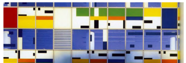
Fig. 173. Detalle paneles de la fachada en el edificio Colorium.
