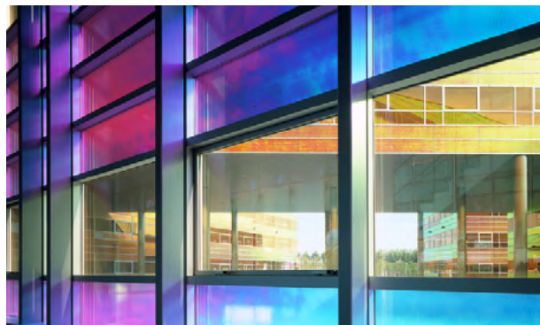
Fig. 81. Edificio La Defense, UnStudio (2004).
