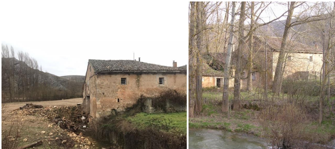
Figura 5. Molino de las Tenerías. Fuente: Elaboraci6n propia
