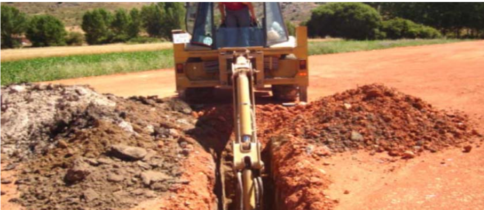
Figura I.A7.14. Excavación de la calicata 2.
