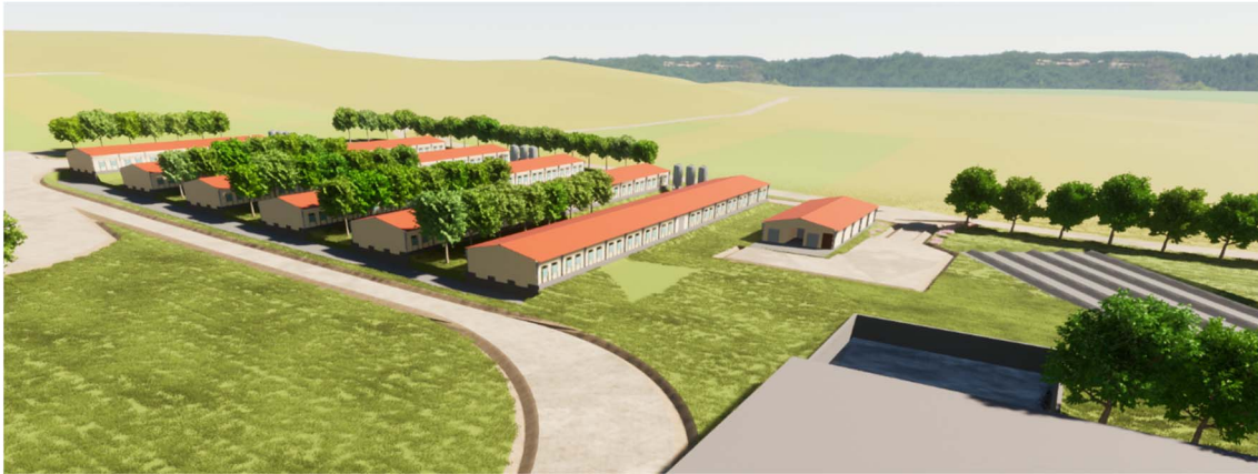
Figura I.A1.4. Simulación virtual de balsa de efluentes existente, junto a la solera en la que se desarrolla el compostaje de los residuos sólidos, la instalación solar fotovoltaica y el conjunto de naves ganaderas. De izquierda a derecha estas son la nave de reposición y recría, las cinco naves de producción y la nave de servicios y almacén de consumibles. Fuente: elaboración propia.
