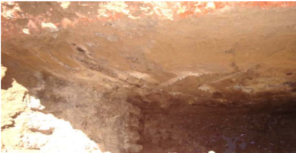
Figura I.A7.17. Aspecto de la calicata 3.
