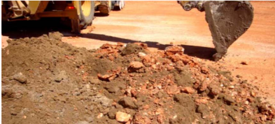
Figura I.A7.16. Material extraído de la calicata 2.
