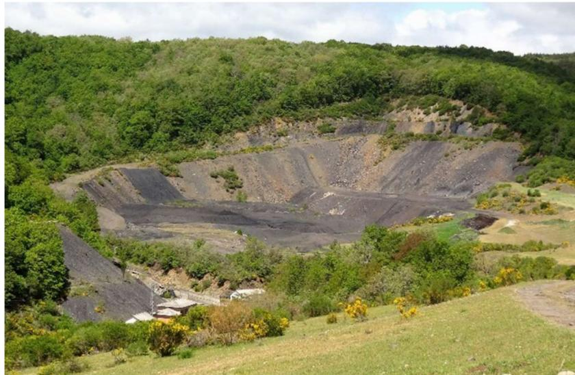
**Figura 1.** Huelco minero en ladera (minería de contorno) en fase de relleno con estériles de minas cercanas (Guardo, Palencia) (foto: C Martínez Ruiz).
