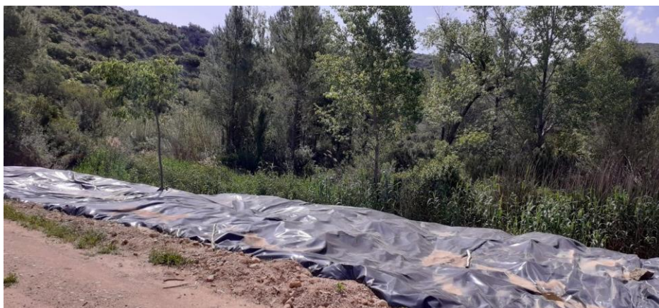
fotografía 8.3.5.1-1-Actuación en uno de los márgenes
