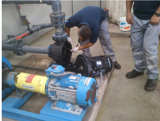
Foto 13. Desmontaje, identificación y diagnóstico de avería en bomba de inyección de reactivo en la estación de "Los Llanos".
