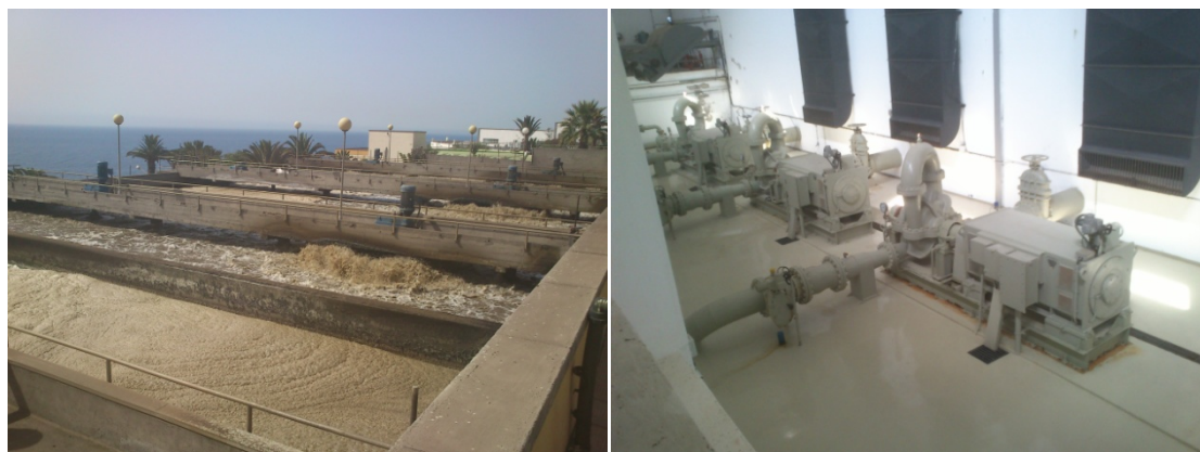
Foto 1. Balsas de aireación. Foto 2. Estación de bombeo de agua tratada hasta el sur de la Isla para su empleo en la agricultura.
