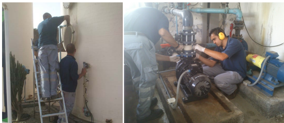
Foto 11. Puesta a punto de torres de desodorización. Foto 12. Reparación de la bomba de inyección de H_2SO_4 .
