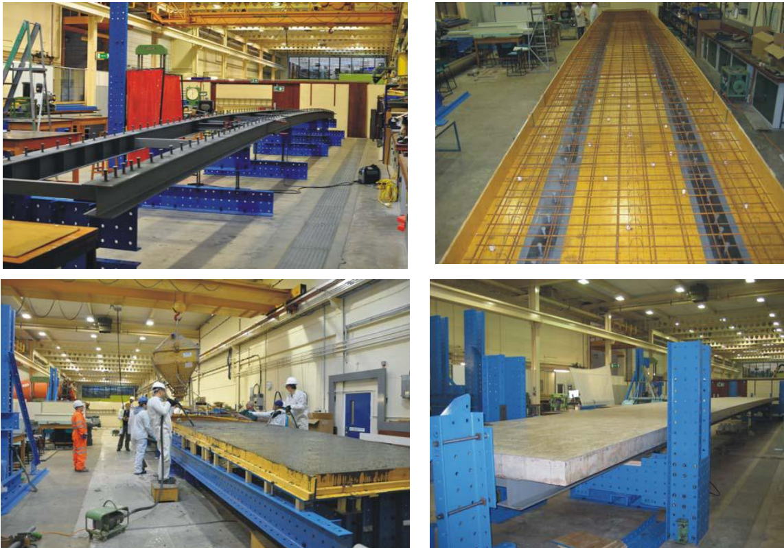
Figura 14. Estructura (arriba-izquierda). Encofrado para vertido (arriba-derecha). Vertido (abajo-izquierda). Estructura final sobre apoyos (abajo-derecha) [59]
