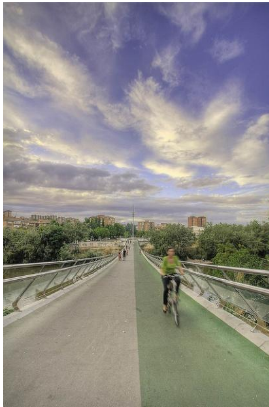
Figura 10. Vista general de la estructura objeto de estudio
