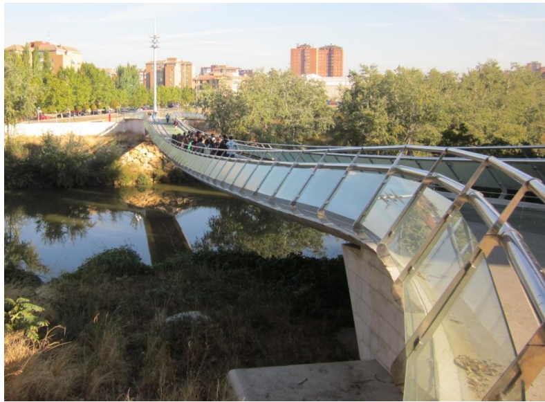
Figura 1: Vista general de la estructura objeto de estudio
