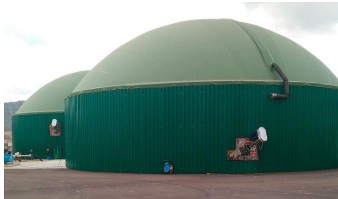
Figura 2. Planta de biogás en Lorca, Murcia 3 .
