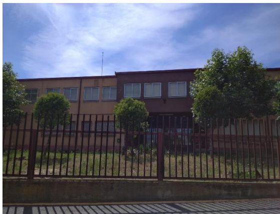
Fig. 3: Edificio 2 del I.E.S. Vía de la Plata Fuente: Fotografía propia.
