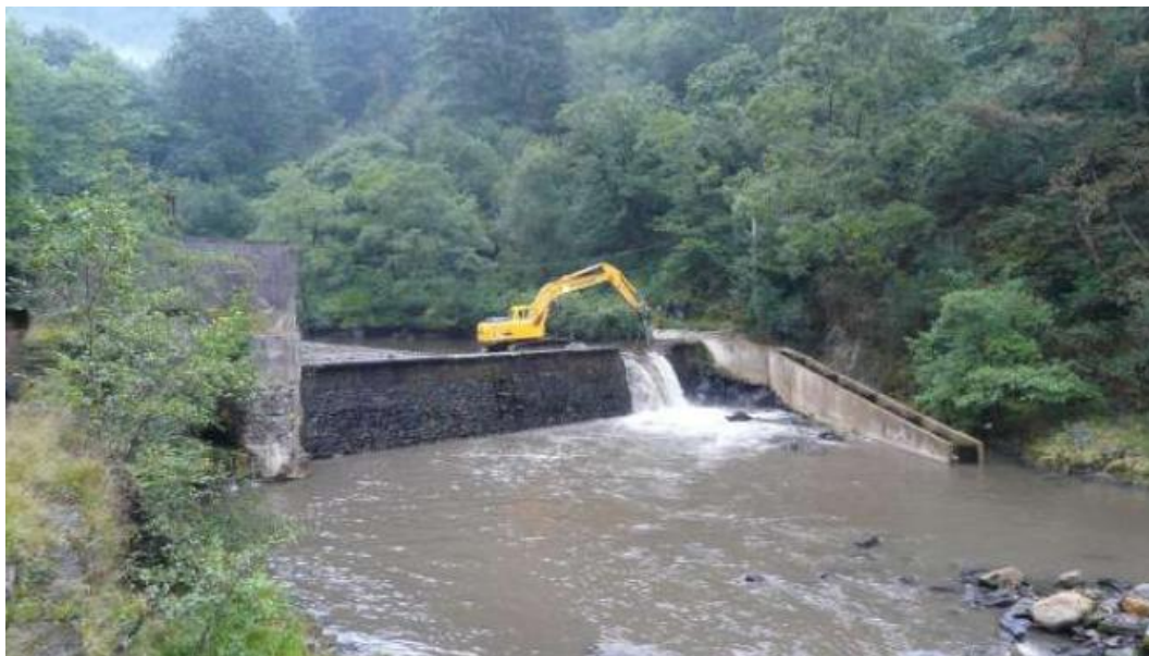
Figura 1. Demolición del azud de Mendaraz, río Urumea (Guipúzcoa). Fuente: http://www.revistaesposible.org/ .
