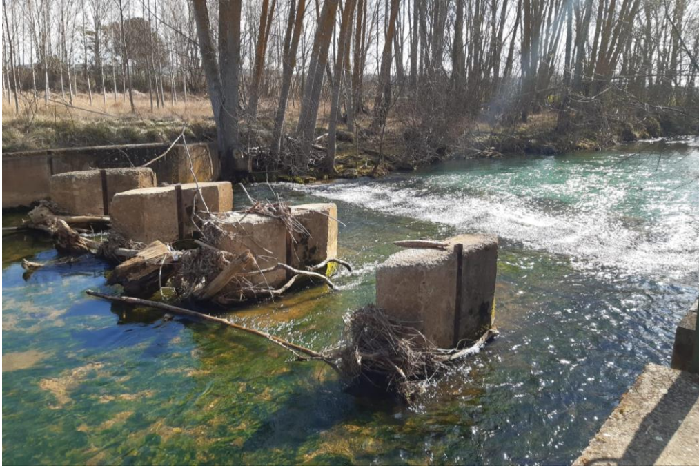
Figura 9. Azud aguas arriba visto desde la margen derecha. Fuente: Propia.
