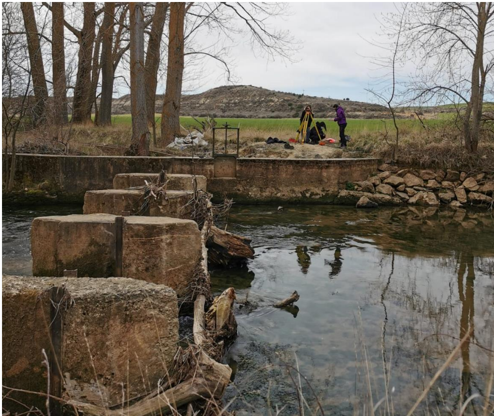
Figura 6. Vista de la margen derecha. Fuente: Propia.
