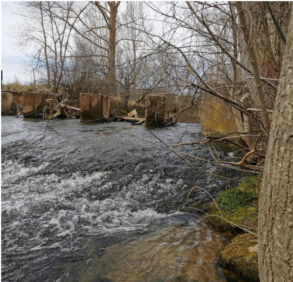
Figura 10. Azud visto desde aguas abajo de la margen izquierda. Fuente: Propia.
