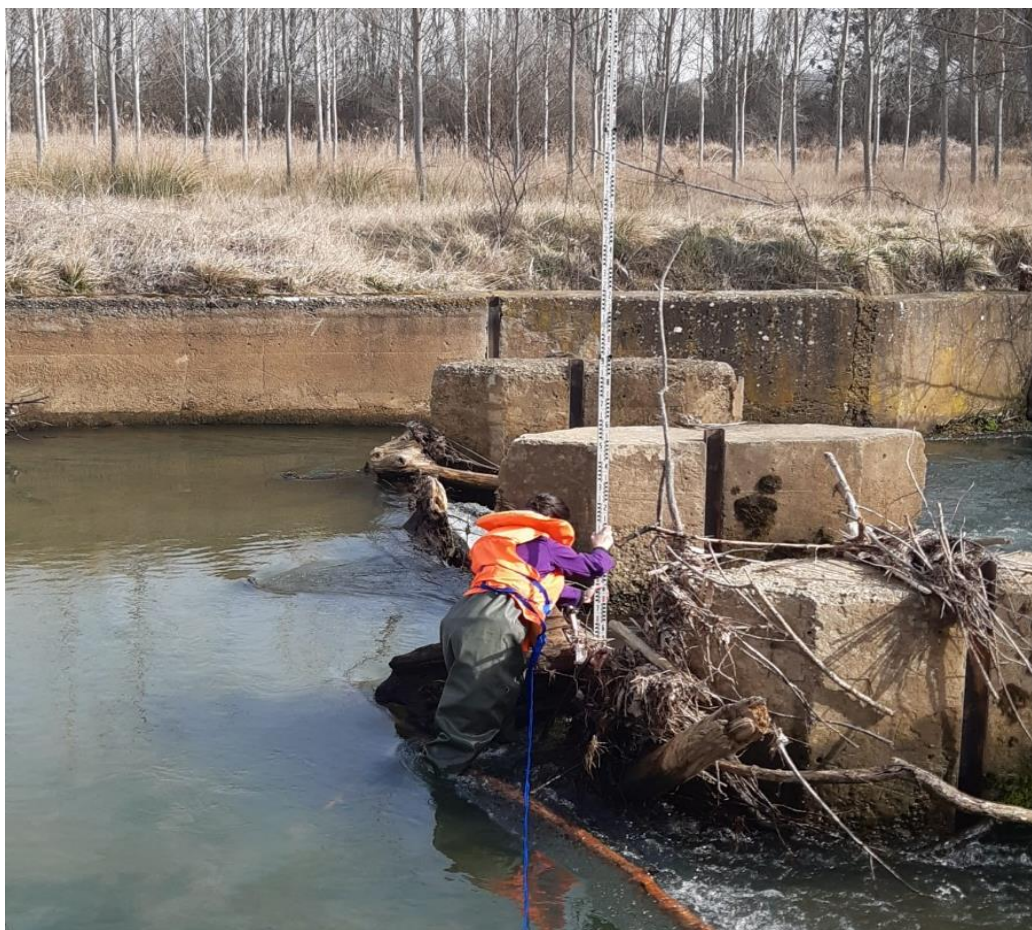
Figura 4. Toma de medidas de dimensionamiento de la presa. Fuente: Propia.
