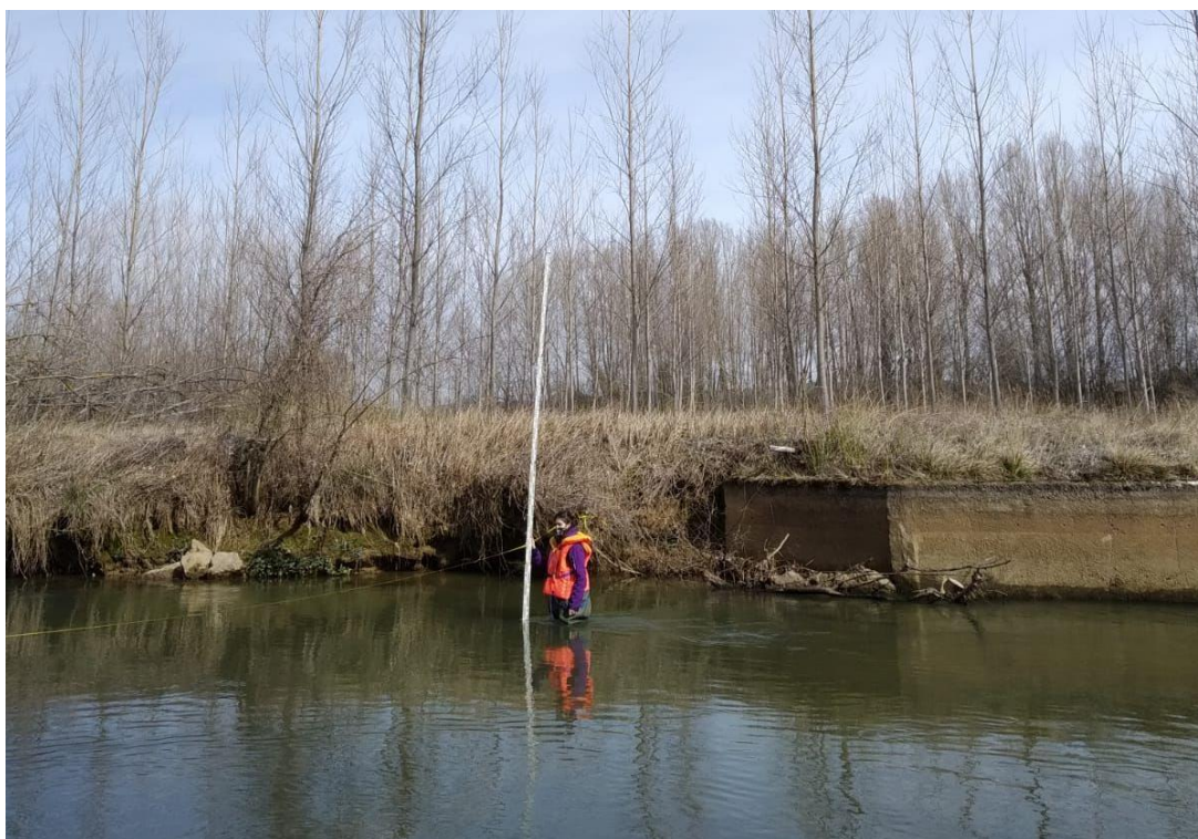
Figura 3. Toma de cotas con el nivel y mira de aluminio en la sección transversal aguas arriba de la presa. Fuente: Propia
