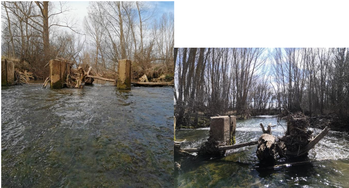
Figura 5. Vista aguas arriba y aguas abajo (de izquierda a derecha) de la presa. Fuente: Propia.
