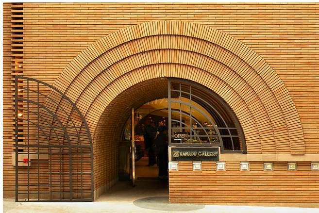
Imagen 22, 23 Tienda V.C. Morris, San Francisco. Diseñado por el arquitecto Frank Lloyd Wright
