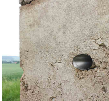
78. Tubo de acero en el exterior.
