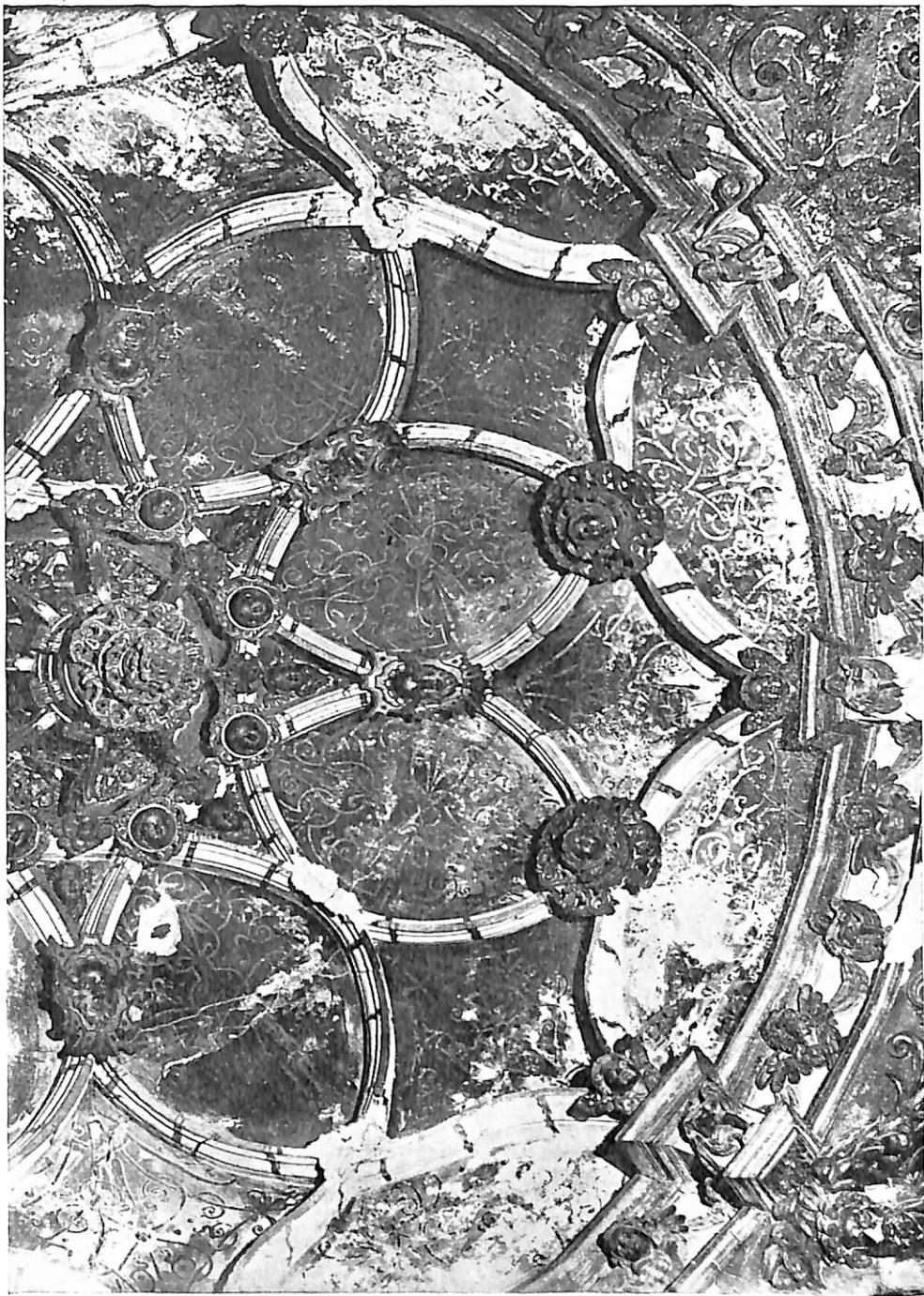
LAMINA XII. — Antigua iglesia de Santa María del Templo en Villalpando. — Cúpula de la capilla subsistente. (Foto del S. E. A. A.).
