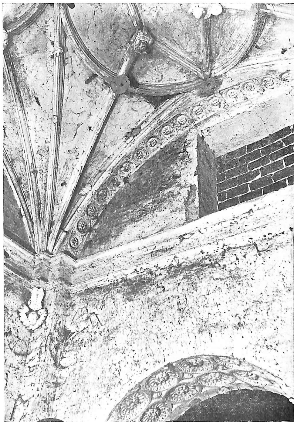
LÁMINA XX. — Casa Blanca. — Detalle de la capilla. (Foto del S. E. A. A.)
