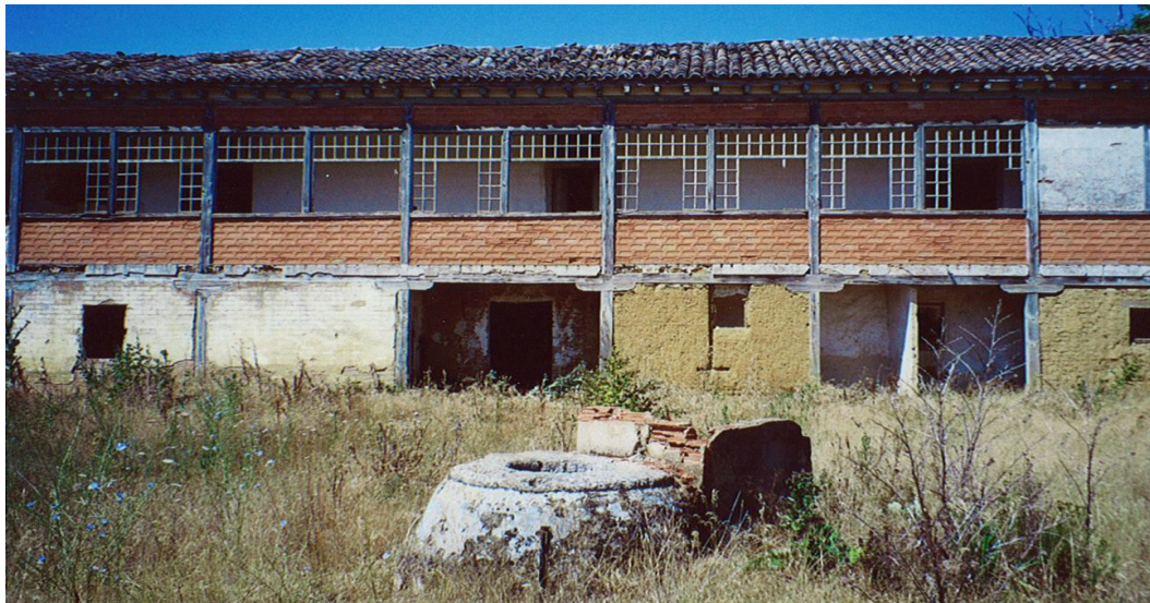
Fig. 24 Hospital Del Gran Caballero. Fachada principal y patio con solarium y pozo de agua para el recinto y servicios asistenciales
