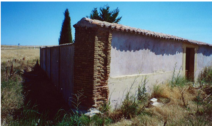
Fig. 25 Esquina de ladrillos que es lo único que se conserva como original del hospital fundado por el Obispo de Palencia en San Nicolas del Real Camino.
