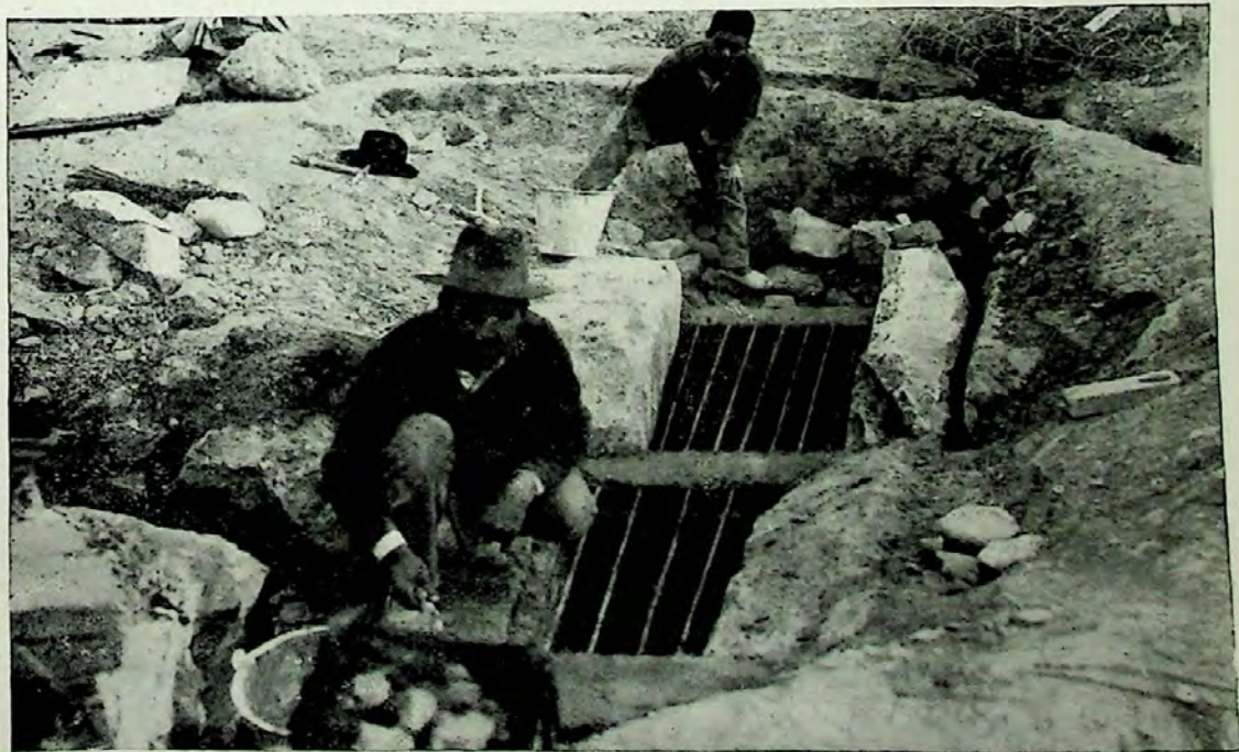
LÁMINA VI.—Construcción de cubiertas correspondientes a la cámara B. y C.
