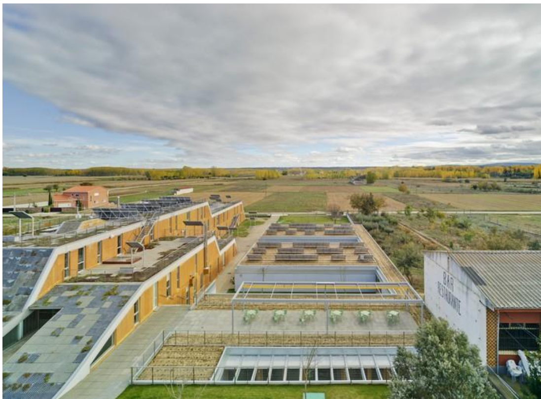
ESTADO ACTUAL DE LA PARCELA CON LA RESIDENCIA ORIGINAL Y LA AMPLIACIÓN. FUENTE: HOSPITECNIA. AUTOR: DAVID FRUTOS
