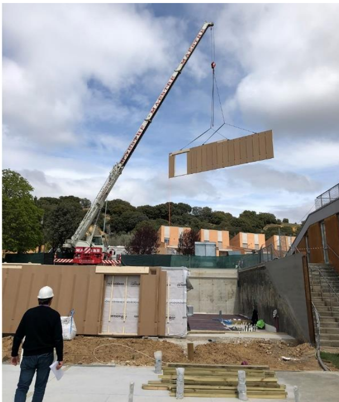
COLOCACIÓN PREFABRICADOS DE MADERA EN OBRA. FUENTE: CSO ARQUITECTOS
