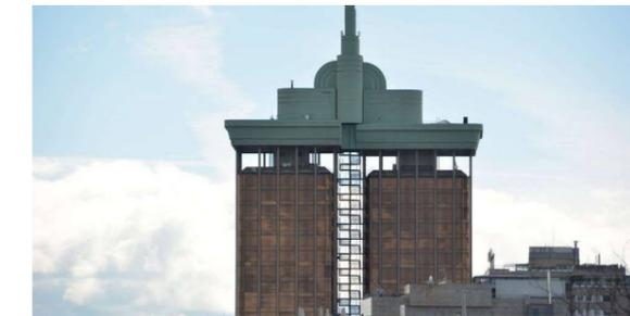
Fig. 5.109. Escalera exterior de unión de torres.
