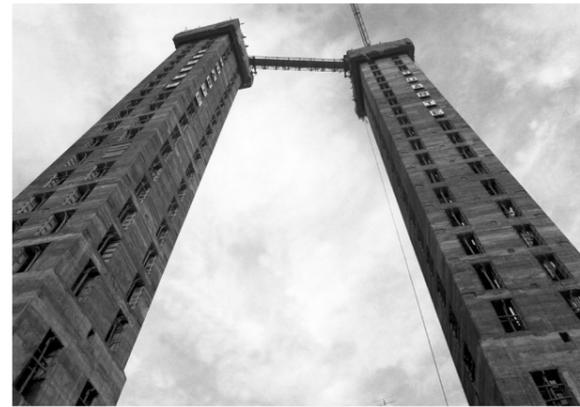
Fig. 5.106. Construcción de la estructura de las torres.
