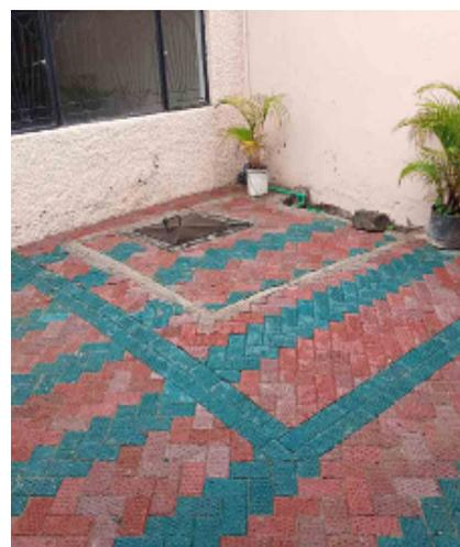
Ilustración 41: Pavimento 33,6 m<sup>2</sup> con adoquines de baja resistencia para residencia. (Gjenge Makers, 2020)
