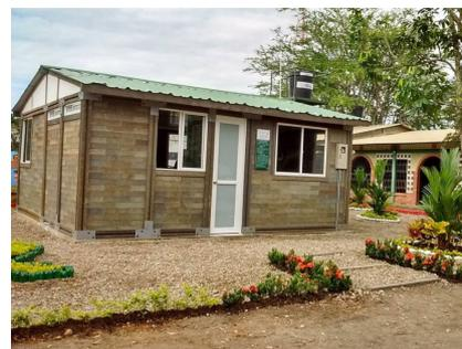
Ilustración 60: Vivienda construida con ladrillos plásticos. (Conceptos Plásticos, s.f.)
