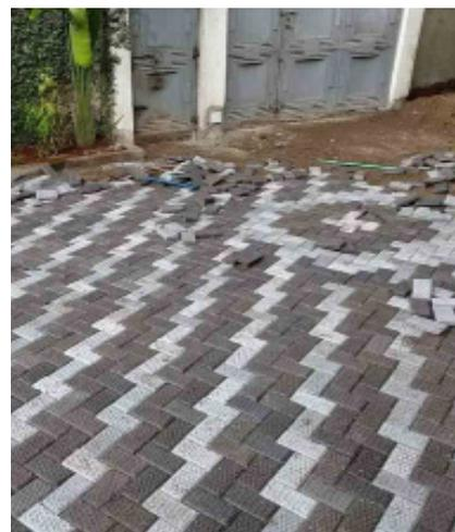
Ilustración 43: Pavimento 71 m<sup>2</sup> con adoquines de baja resistencia para residencia. (Gjenge Makers, 2020)
