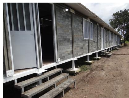
Ilustración 62: Barrio construido con ladrillos plásticos. (Conceptos Plásticos, s.f.)
