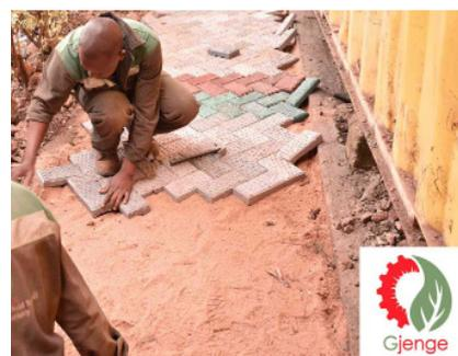
Ilustración 40: Pavimento 101 m<sup>2</sup> con adoquines de resistencia moderada. (Gjenge Makers, 2020)
