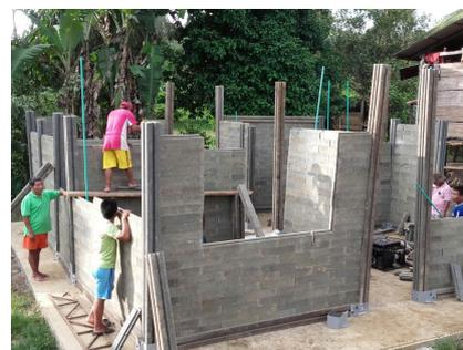
Ilustración 61: Vivienda de ladrillos plásticos en construcción. (Conceptos Plásticos, s.f.)
