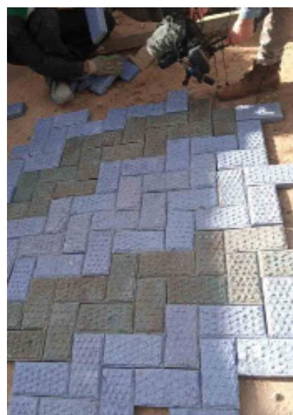
Ilustración 42: Pavimento 12 m<sup>2</sup> con adoquines de alta resistencia para aparcamiento. (Gjenge Makers, 2020)
