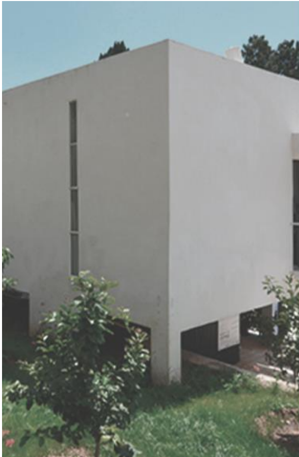
(fig. 26) Detalle de las ventanas alargadas y los pilares embebidos en el terreno por diseño en E.1027.
