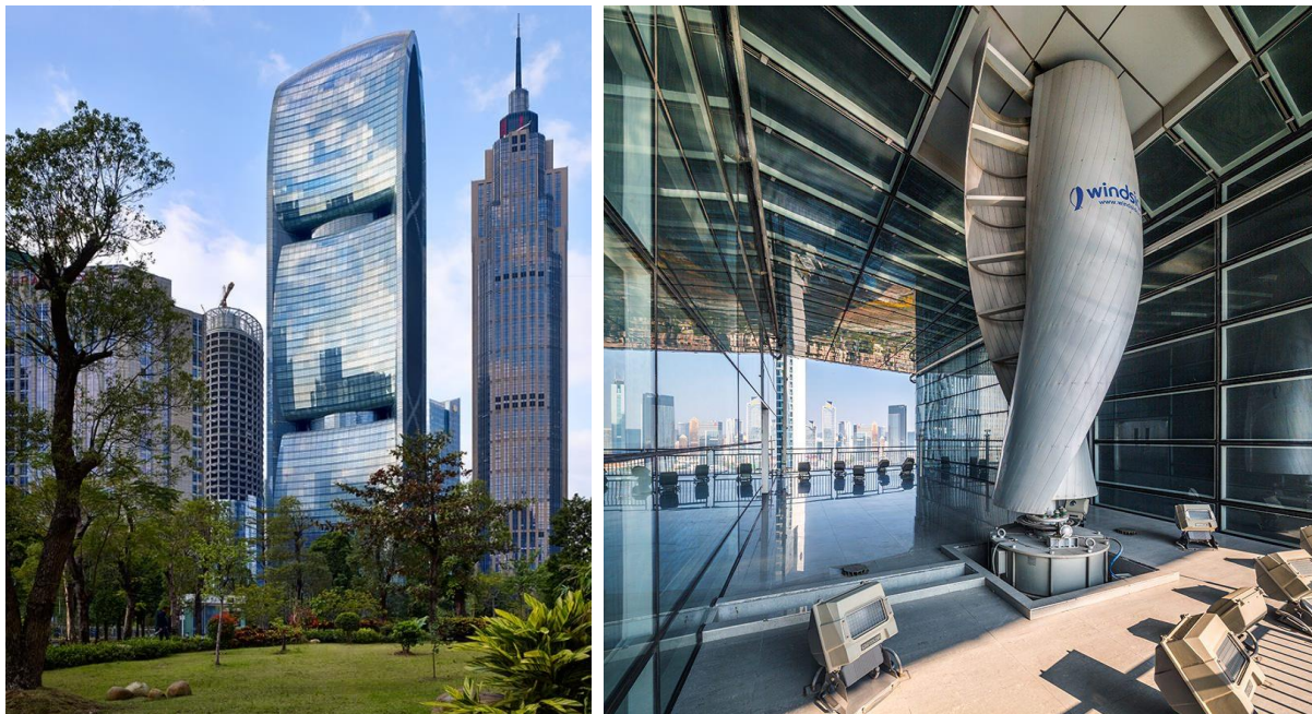
20. Izquierda: Pearl River Tower. Derecha: Aerogeneradores instalados en la Pearl River Tower.
