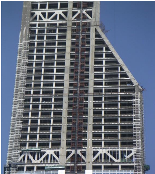
15. Izquierda: Celosías estructurales en plantas técnicas en el edificio Shimao International Plaza (Shanghái, 2006). Derecha: Núcleo de comunicaciones tipo.
