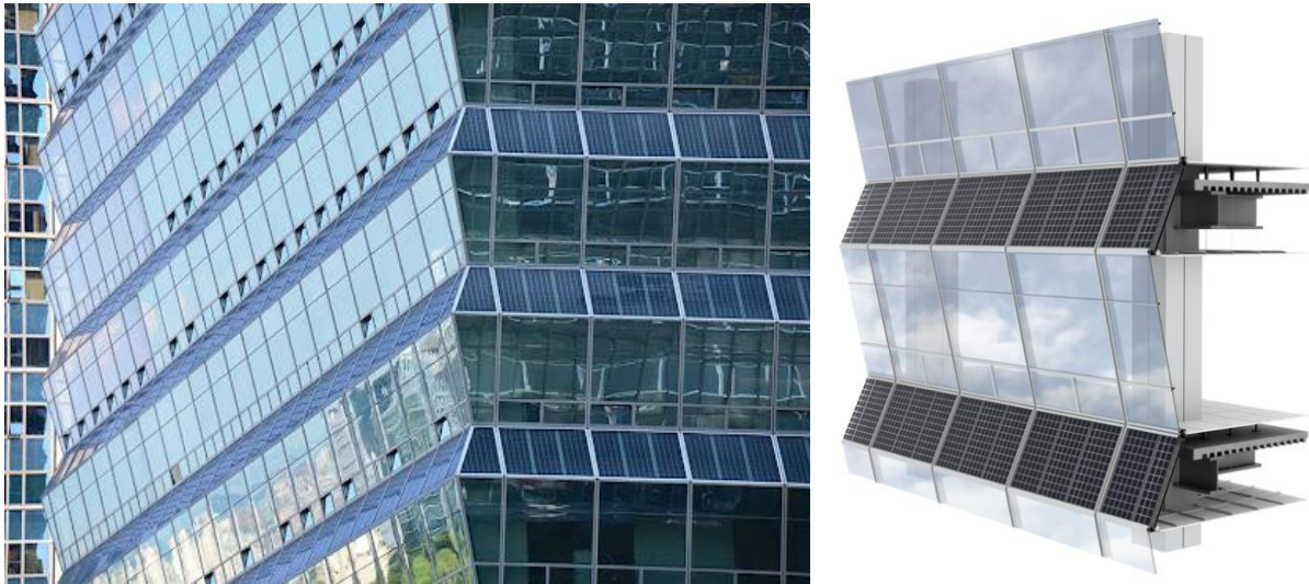
12. Paneles solares fotovoltaicos en la fachada de la FKI Tower
