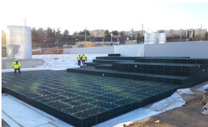
Figura 5.5.5: Gran extensión de un depósito de infiltración. Fuente: ver anexo 1.
