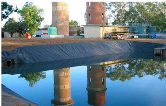
Figura 5.5.12: Estanque de retención húmedo en zona industrial. Fuente: ver anexo 1
