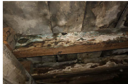
Figura 68. Ejemplo de hongo xilófago de pudrición blanca Fuente: https://www.tecmadera.com/
