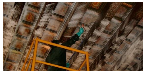
Figura 154. Imagen de como se proyecta productos de protección de la madera contra agentes xilófagos. Fuente: https://ctsnorte.com/
