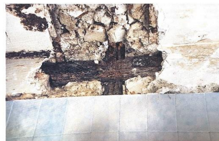
Figura 69. Ejemplo de hongo xilófago de pudrición parda Fuente: Extraída del libro Protección precentiva de la madera
