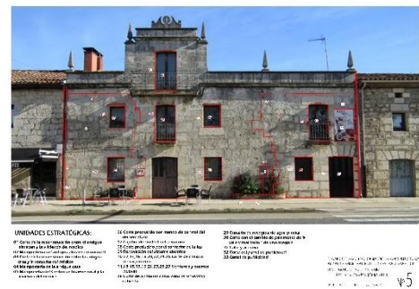
Figura 57. Imagen del plano número 5 donde se indican todas las unidades estratigráficas de la fachada principal
