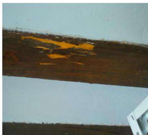
Figura 88. Imagen de una vigueta afectada por ataques de insectos xilófagos en la zona central. Fuente: Foto propia
