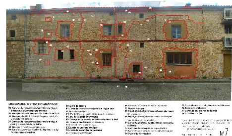
Figura 60. Imagen del plano número 7 donde se indican todas las unidades estratigráficas de la fachada trasera
