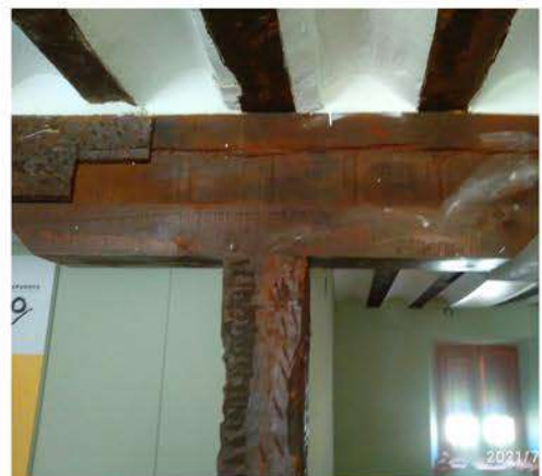
Figura 91. Imagen frontal de la unión entre pie derecho y viga madera Fuente: Foto propia
