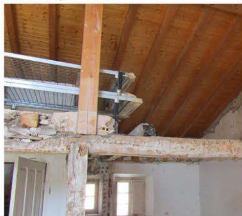
Figura 97. Imagen frontal donde se marca la falta de continuidad Fuente: Foto propia
