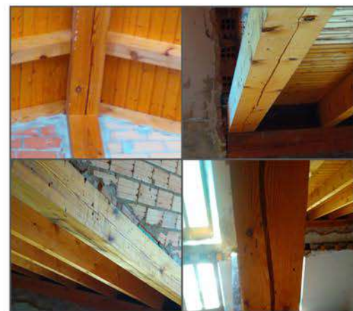
Figura 103. conjunto de imagenes donde se ven diferentes fendas en el edificio Fuente: Foto propia
