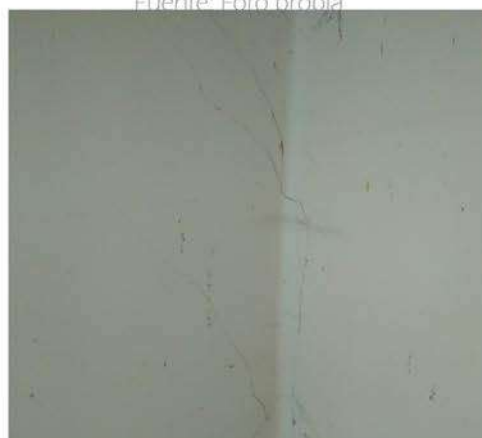
Figura 118: Imagen que muestra las fisuras diagonales en la esquina. Fuente: Foto propia
