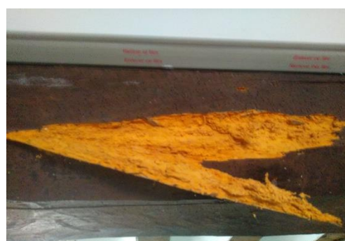
Figura 73. Imagen de ataque de Cerambícido en el edificio de estudio, desde el tamaño de los orificios, hasta la galería de interiores y el serrín que producen Fuente: Foto propia
