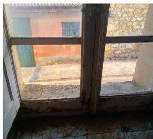
Figura 144. Imagen de la ventana de la fachada norte de la planta primera Fuente:Foto propia
