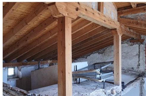
Figura 147. Imagen que representa que la estructura de madera del edificio se encuentra en una clase de riesgo 2 Fuente: Héctor Fernandez
