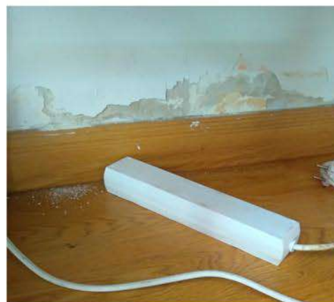
Figura 133. Imagen de la humedad en el arranque del muro que seora el edificio Fuente: Foto propia
