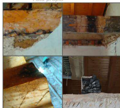
Figura 106: Conjunto de imagenes de diferentes viguetas quemadas alrededor del edificio. Fuente: Foto propia
