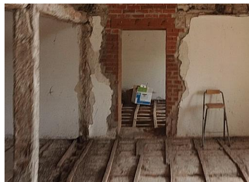
Figura 62. Vista interior donde ese ven los dos tipos de forjados
