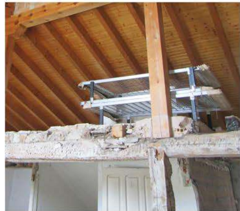
Figura 96. Imagen extraña unión en la estructura Fuente: Foto propia
