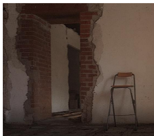
Figura 64. Imagen donde se aprecia el muro interior de grandes dimensiones Fuente: Héctor Fernández
