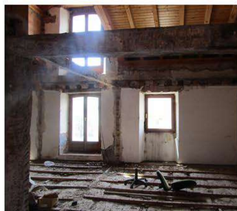
Figura 112. Imagen que muestra el deterioro del forjado y la falta de acabado. Fuente: Foto propia
