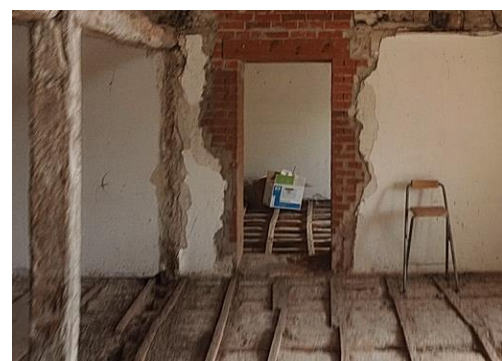
Figura 21. Vista interior donde ese ven los dos tipos de forjados
