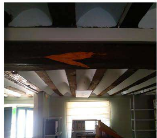
Figura 85. Imagen de la viga afectada por ataques de insectos xilófagos. Fuente: Foto propia
