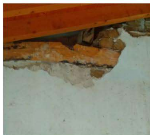
Figura 82. Imagen de la viga empotrada en la pared afectada por hongos xilofagos Fuente: Foto propia
