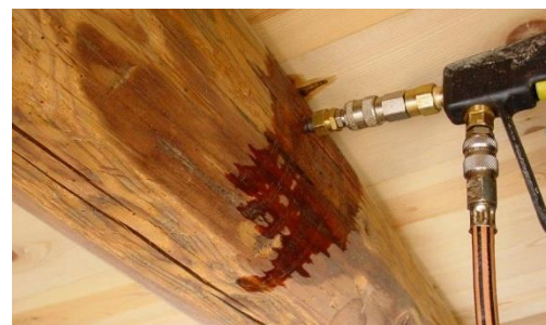
Figura 155. Imagen del proceso de inyección de productos líquidos para proteger la madera Fuente: https://ambientecero.es
