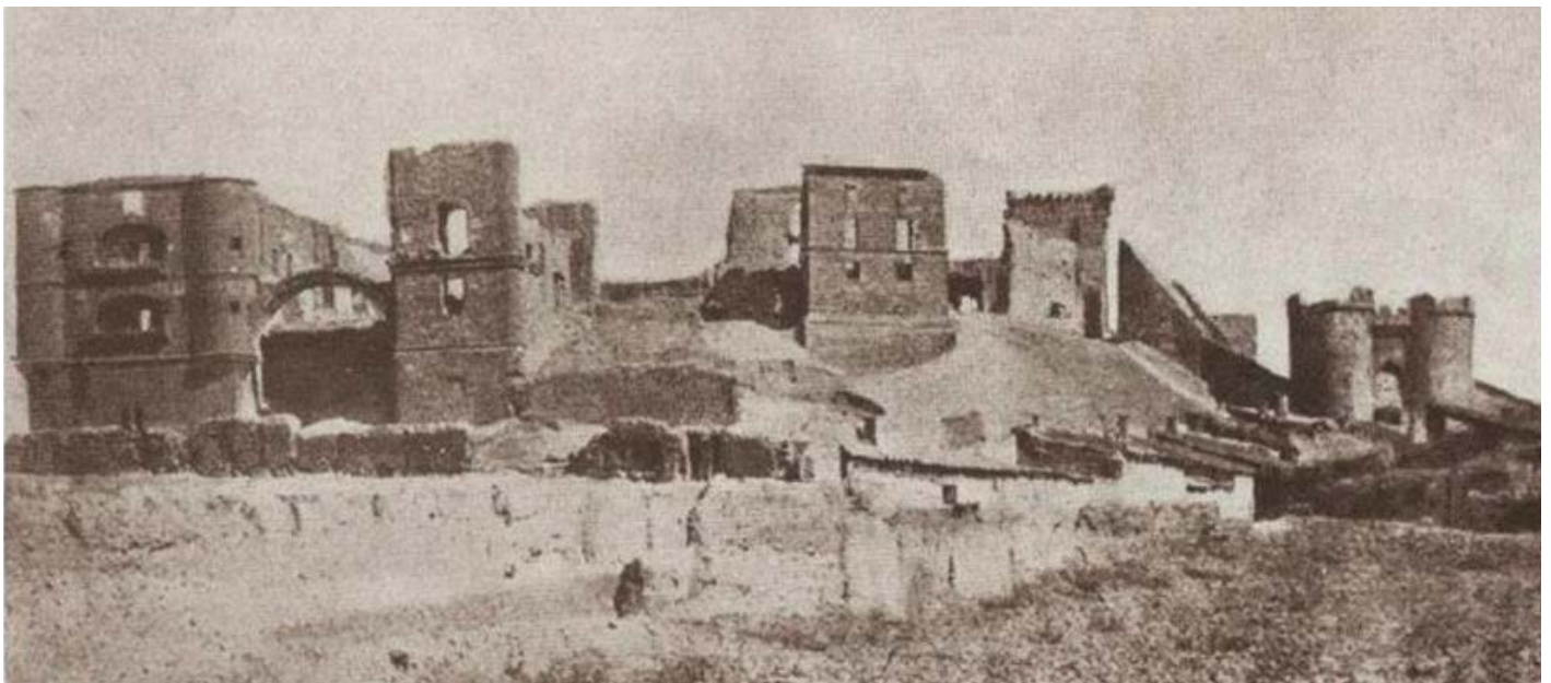
Fig. 64 Gómez-Moreno. "Benavente. Ruinas de su castillo antes del derribo". Fachada S.
