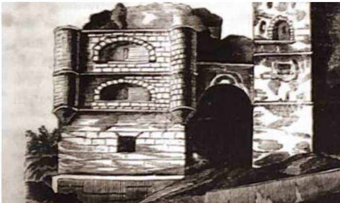
Fig. 38 Torre del caracol
