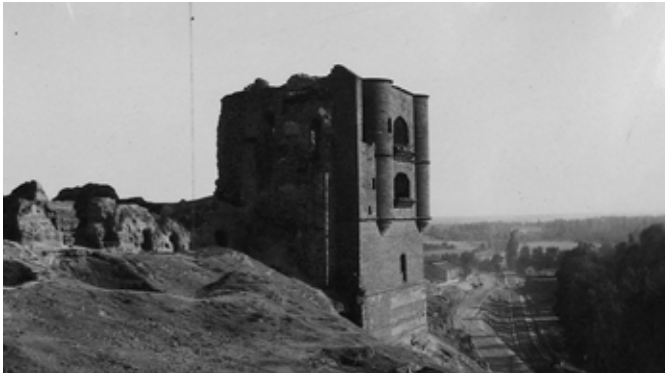
Fig. 36 Torre del caracol
