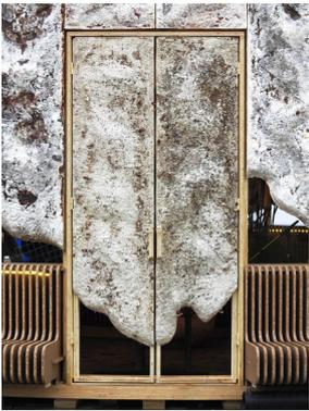
El pabellón está enteramente construido por materiales de origen orgánico, los marcos de la estructura de madera, sobre los que se encajan los paneles de micelio que constituyen el cerramiento, al ser al exterior estos tuviera que ser protegidos por una capa protectora de revestimiento orgánico.
