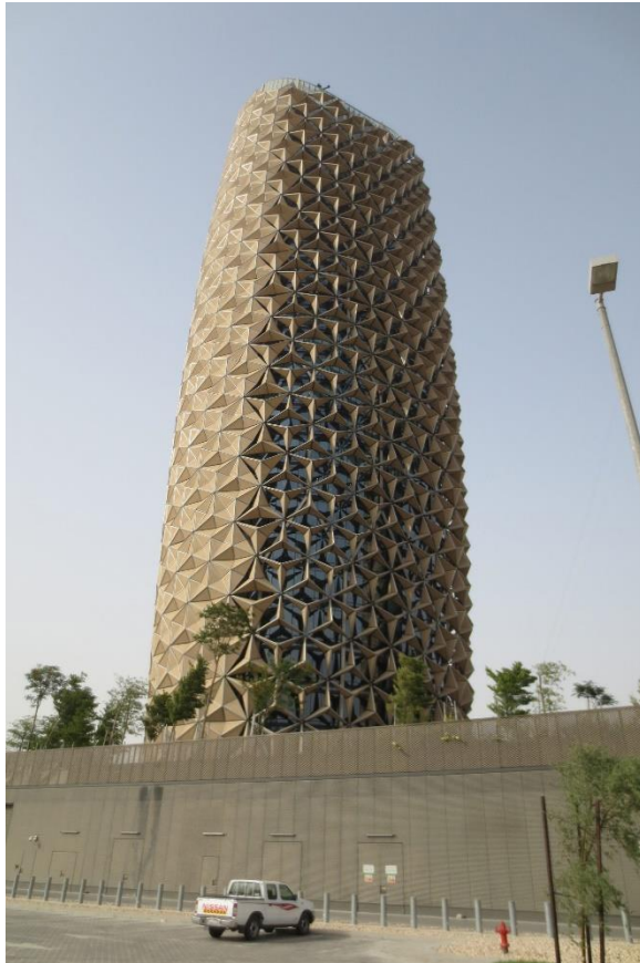
Imagen 60. Funcionamiento progresivo según el recorrido solar. Fuente: https://es.wikiarquitectura.com/edificio/torres-al-bahar/
