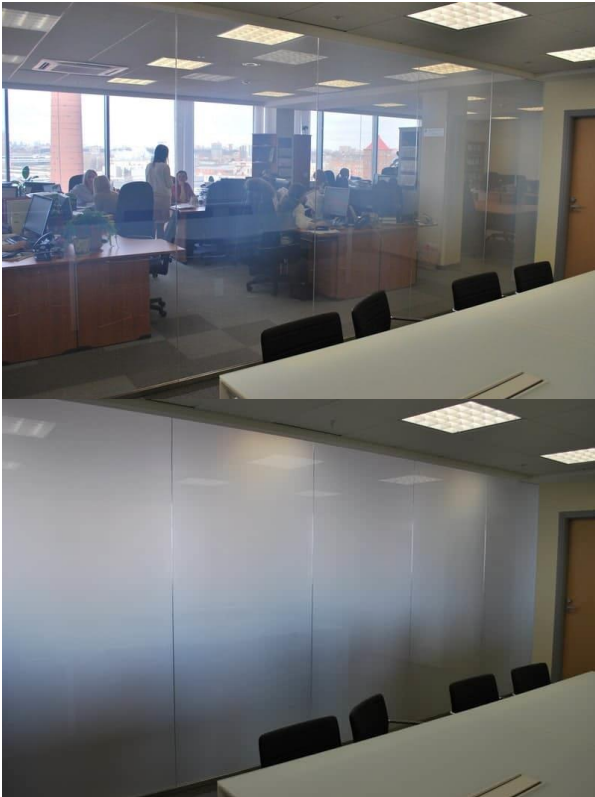
Imagen 37. Funcionamiento del cristal LCD en una mampara interior. Fuente: https://www.glasstek.es/laminar-vidrio-con-eva/aplicaciones-del-eva/laminar-vidrio-con-lamina-lcd-privalite-y-eva-evguard/
