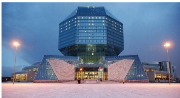
Imagen 69. Imagen exterior del acceso al edificio. Fuente: https://es.wikiarquitectura.com/edificio/biblioteca-nacional-de-bielorrusia/
