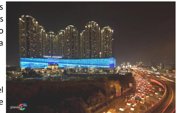
Imagen 40. Taman Angrek 2011, (Indonesia, Yakarta) El Grupo Mulia. Fachada de 354 metros de longitud, curva y 25 de alto. Se adapta a la forma del edificio. + de 8.500.000 píxeles Led RGB. Fuente: https://awards.mediaarchitecture.org/mab/project/121
