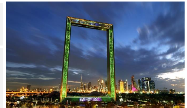
Imagen 121. Dubai Frame (Dubai) de Fernando Donis (2018). Contiene vidrios fotovoltaicos de color opacos en su envoltorio. Fuente: https://www.onyxosolar.es/dubai-frame
