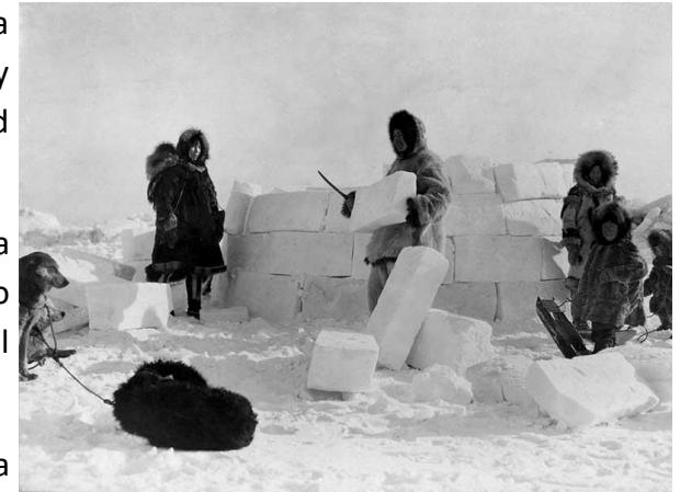
Imagen 8: Construcción de un iglú. Fuente: https://travesiapirenaica.com/como-construir-un-iglú/
