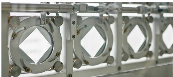
Imagen 53. Diafragmas pequeños conectados con la barra que los abre y cierra. Fuente: https://www.plataformaarquitectura.cl/c/02-265617/clasicos-de-arquitectura-instituto-del-mundo-arabe-jean-nouvel/51ad51e2b3fc4b225b000014
