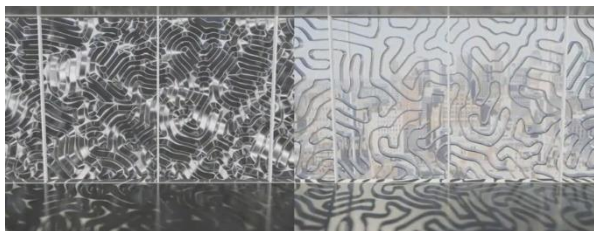
Imagen 34. Fachada homeostática Decker Yeadon Architects. Fuente:
