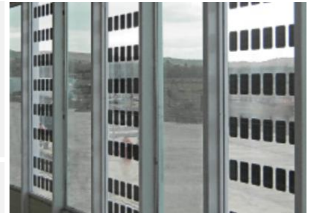
Imagen 120. Vidrio fotovoltaico. Fuente: https://www.onyxosolar.es/hospital-de-punta-arenas
