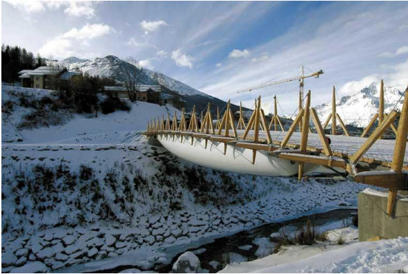
Imagen 25. Pasarela para esquiadores de 52 m de luz en Lanslevillard (Francia). Fuente: https://tectonica.archi/materials/sistema-estructural-con-elementos-neumaticos/
