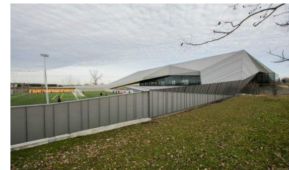
Imagen 82. Estadio de fútbol en Montreal Hcma Architectes (2015) con envoltorio de zinc. Fuente: https://elzinc.es/listings/estadio-futbol-montreal-cubierta-y-fachada-en-zinc/
