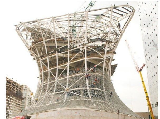
Imagen 27: Proceso de construcción del Museo Soumaya en Ciudad de México (2010). Fuente: https://www.plataformaarquitectura.cl/cl/02-56016/en-construccion-museo-soumaya-ciudad-de-mexico-lar
