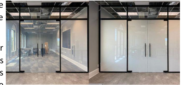
Imagen 35. Funcionamiento de un vidrio electrocrómico interior. Fuente: https://teoriadeconstruccion.net/blog/vidrio-electrochromico/
