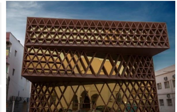
Imagen 94. Biblioteca Al Khalifeyeh (Bahrein) de Ismail Khonji Architects (2017). Fachada y celosía de FRP con capacidad estructural. Fuente: http://www.bfginternational.com/architecture-and-infrastructure/projects/al-khalifeyeh-library-bahrain
