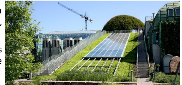
Imagen 9: Cubierta ajardinada con captadores fotovoltaicos. Fuente: https://www.cubiertasajardinadas.com/wp-content/gallery/cubiertas-ajardinadas-1/jardin-con-placas-solares.jpg
