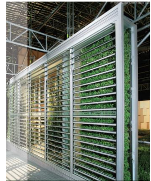
Imagen 16: Imagen prototipo fachada vegetal invernadero. Fuente: https://inarquia.es/fachadas-vegetales-sistemas-constructivos/
