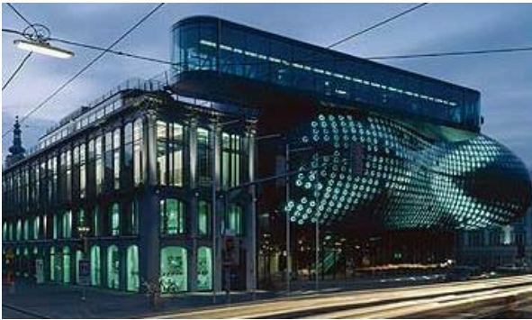
Imagen 45. Kunsthaus (Graz, Austria) de Peter Cook y Colin Fourier (2003). Fachada multimedia con iluminación de fluorescentes circulares.
