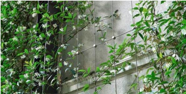
Imagen 14: Sistema de cables trenzados. Fuente: https://blog.laminasyaceros.com/blog/fachadas-verdes-sistema-de-cables-trenzados
