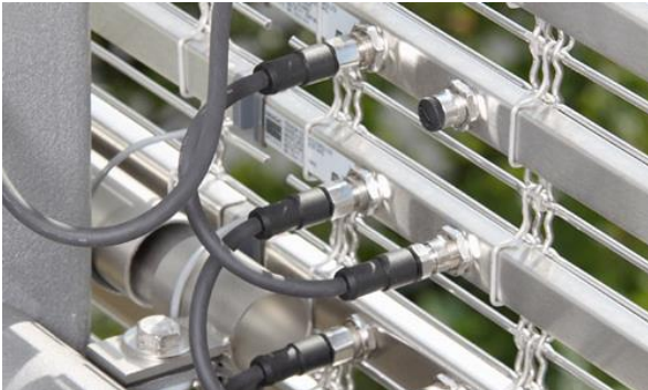
Imagen 108. Malla metálica con barras LED incorporadas. https://www.telas-arquitectonicas.com/es/galeria-de-proyectos/details/fachada-multimedia-transparente-haver-boecker/
