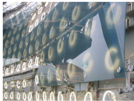
Imagen 66. Sistema de fluorescentes y paneles de metacrilato. Fuente: https://es.wikiarquitectura.com/edificio/kunsthau-de-graz/
