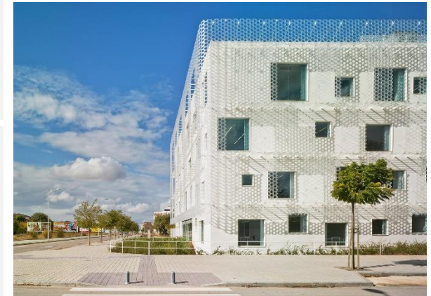
Imagen 98. Sede Central de FEDA (Albacete) de COR ASOCIADOS ARQUITECTOS (2013). Celosía de metacrilato. Fuente: https://cor.cc/project/sede-fed/
