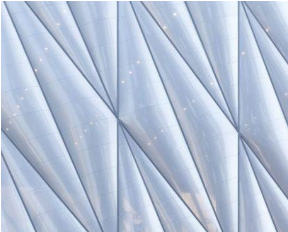
Imagen 99. Cojines de EFTE instalados en fachada. Fuente: https://revistaestilopropio.com/nota/generos-superficies-etfe-nuevo-material-tendencia/
