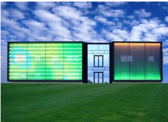
Imagen 71. Sistema encendido. Fuente: https://architizer.com/projects/atelier-a-torce/
