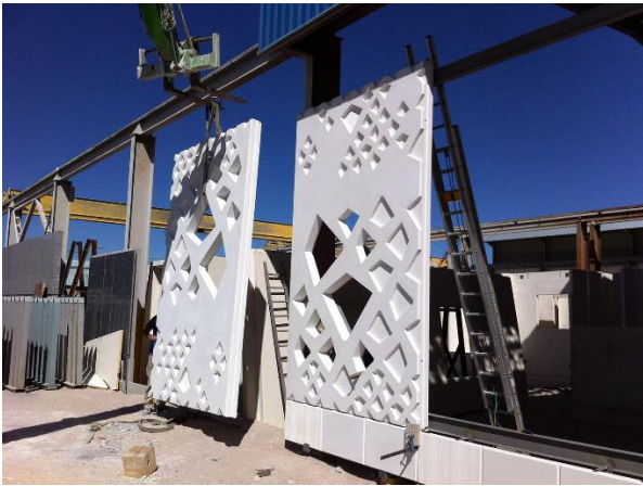
Imagen 122. Paneles de GRC instalándose en obra. Fuente: https://www.prehorquisa.com/es/grc.html
