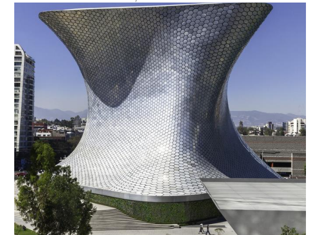
Imagen 28: Museo Soumaya en Ciudad de México (2010) con paneles modulares de fachada incorporados. Fuente: https://www.plataformaarquitectura.cl/cl/02-314551/museo-soumaya-fr-ee-fernando-romero-enterprise/52954374e8e44ead2a000017-museo-soumaya-fr-ee-fernando-rome
