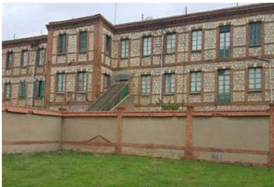
Fig.13, 14, 15, 16. Imágenes del estado relativamente reciente de alguno de los edificios del conjunto fabril.
