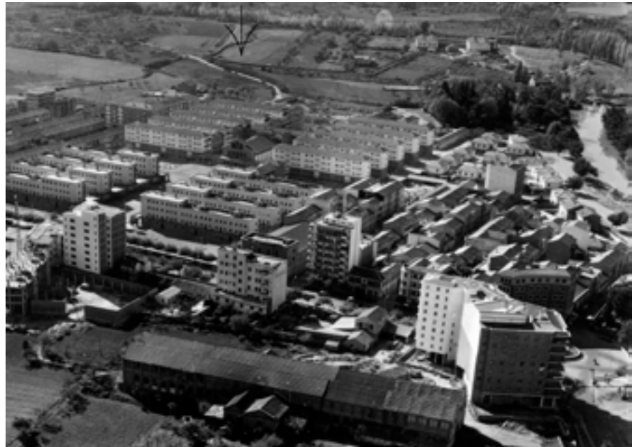
Fig. 9. Vista aérea de las Casas del Hogar (los bloques lineales paralelos), en la parte inferior de la imagen se puede observar la desaparecida fábrica de mantas de Demetrio Caseñé y en la parte superior junto al río Carrión las edificaciones que componían el conjunto industrial del Prado de Lana.
