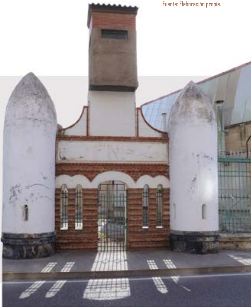
Fig. 50. Puerta acceso secundario. Desahabilitada en el presente. Fuente: Elaboración propia.
