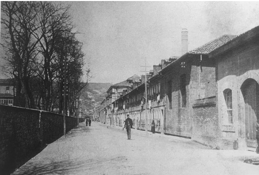
Fig 28. Casas para obreros de la fábrica siderúrgica de Duro Felguera, 1912.
