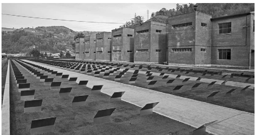
Fig 64. Nueva Casa de aseos del Pozo Sotón. San Martín del Rey Aurelio.
