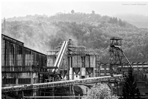
Fig 54. Lavadero de Modesta, Sama de Langreo, derruido por un incendio en 2007.
