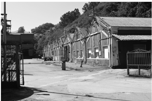
Fig 63. Antigua Casa de aseos del Pozo Sotón. San Martín del Rey Aurelio.
