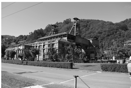
Fig 73. Casa de máquinas y los dos castilletes del Pozo Sotón. San Martín del Rey Aurelio. Fotografía del Autor. 2021
