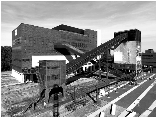
Fig 107. Zeche Zollverein (Alemania) imagen durante la intervención de OMA. 2006
