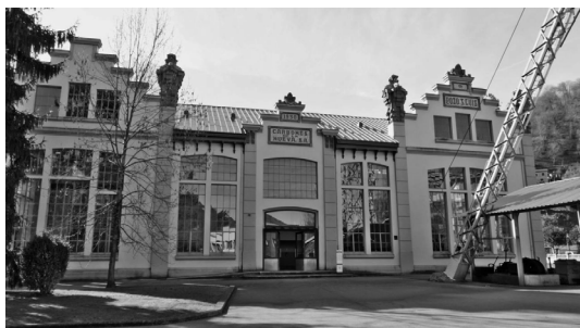
Fig 72. Casa de máquinas Pozo San Luis, Art Déco, Samuño. 1930
