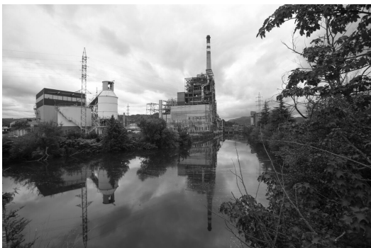
Fig 52. Central térmica de Lada. Fotografía del Autor.
