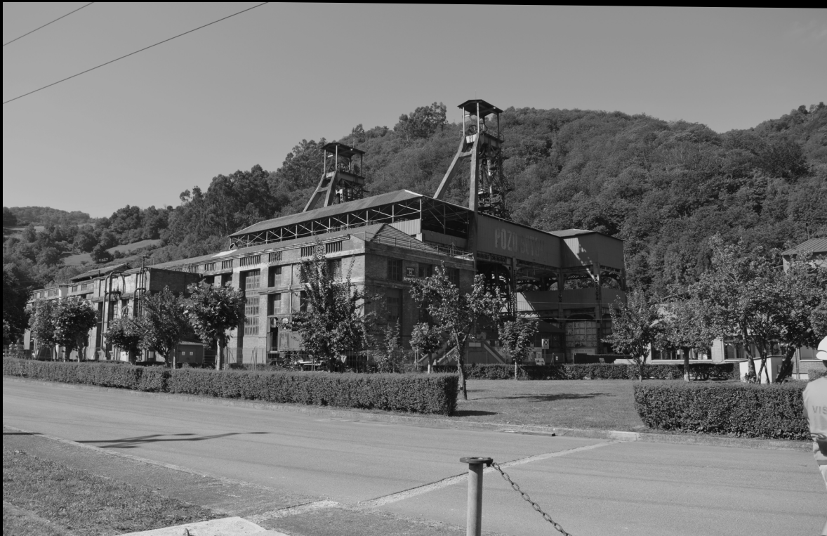
Fig 83. Sala de Maquinas y Castillete del Pozo Sotón. Fotografía propia.
