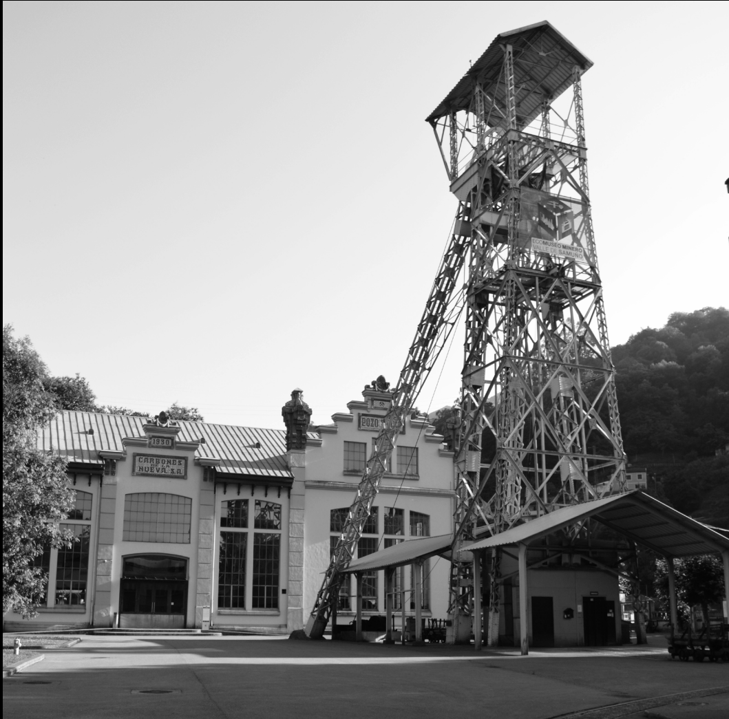
Fig 86. Sala de Maquinas, castillete y embarque del Pozo Fondón. Fotografía propia.
