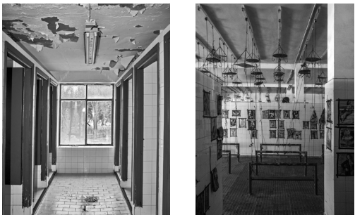
Fig 62. Interior, Casa de aseos del Pozo Sotón. San Martín del Rey Aurelio.
