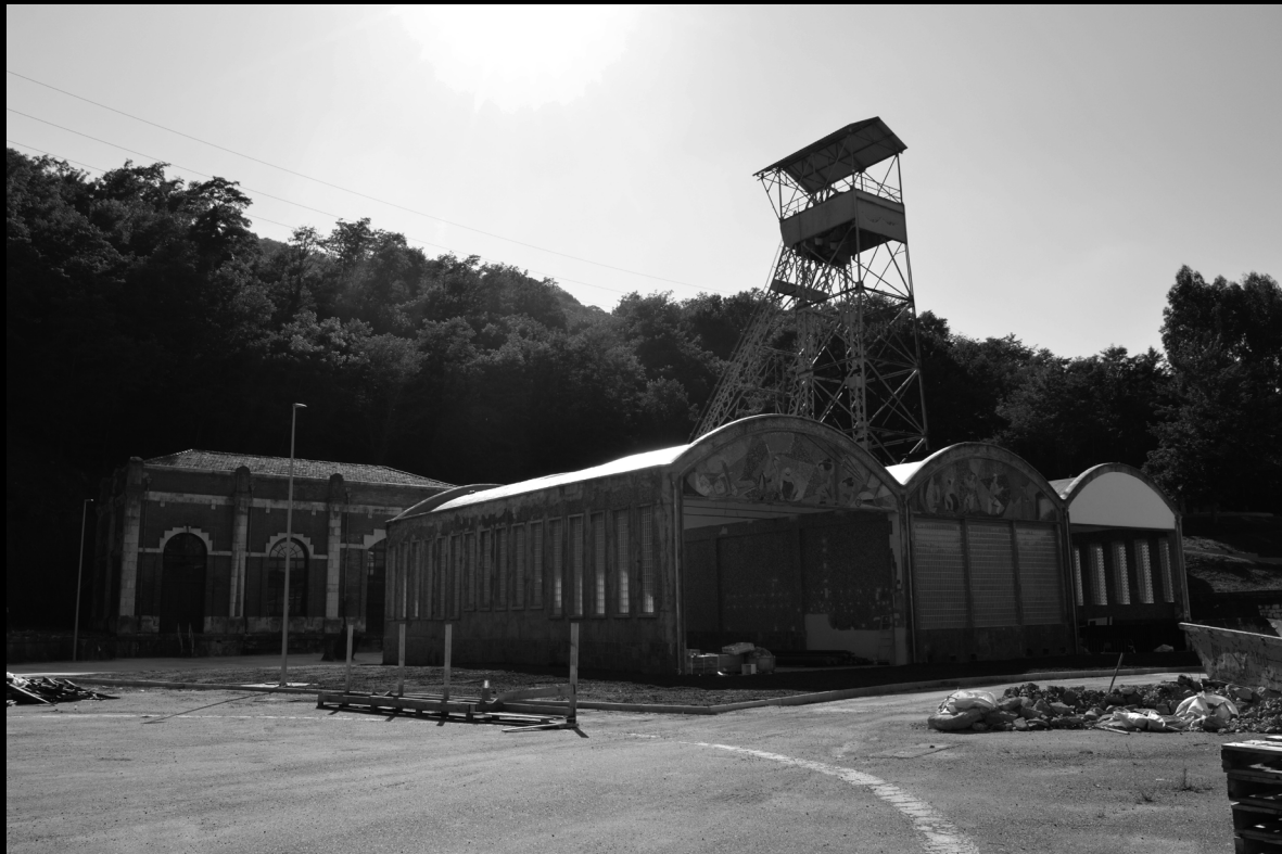
Fig 84. Sala de Maquinas, castillete y embarque del Pozo Fondón. Fotografía propia.
