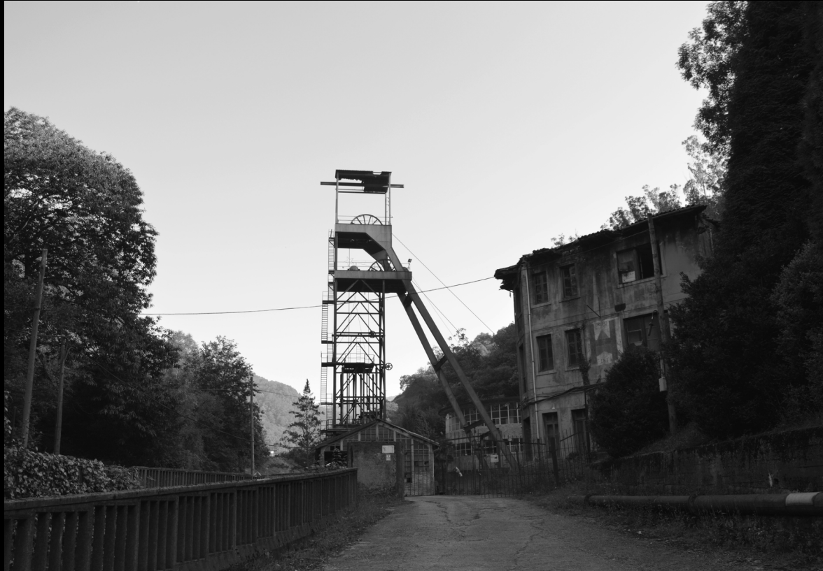
Fig 87. Acceso a el conjunto del Pozo Samuño. Fotografía propia.
