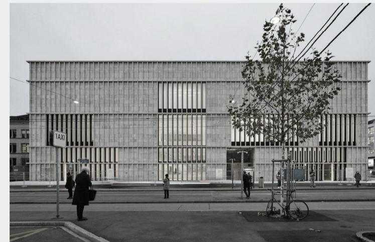
Ampliación Kunsthhaus, Zurich - David Chipperfield
