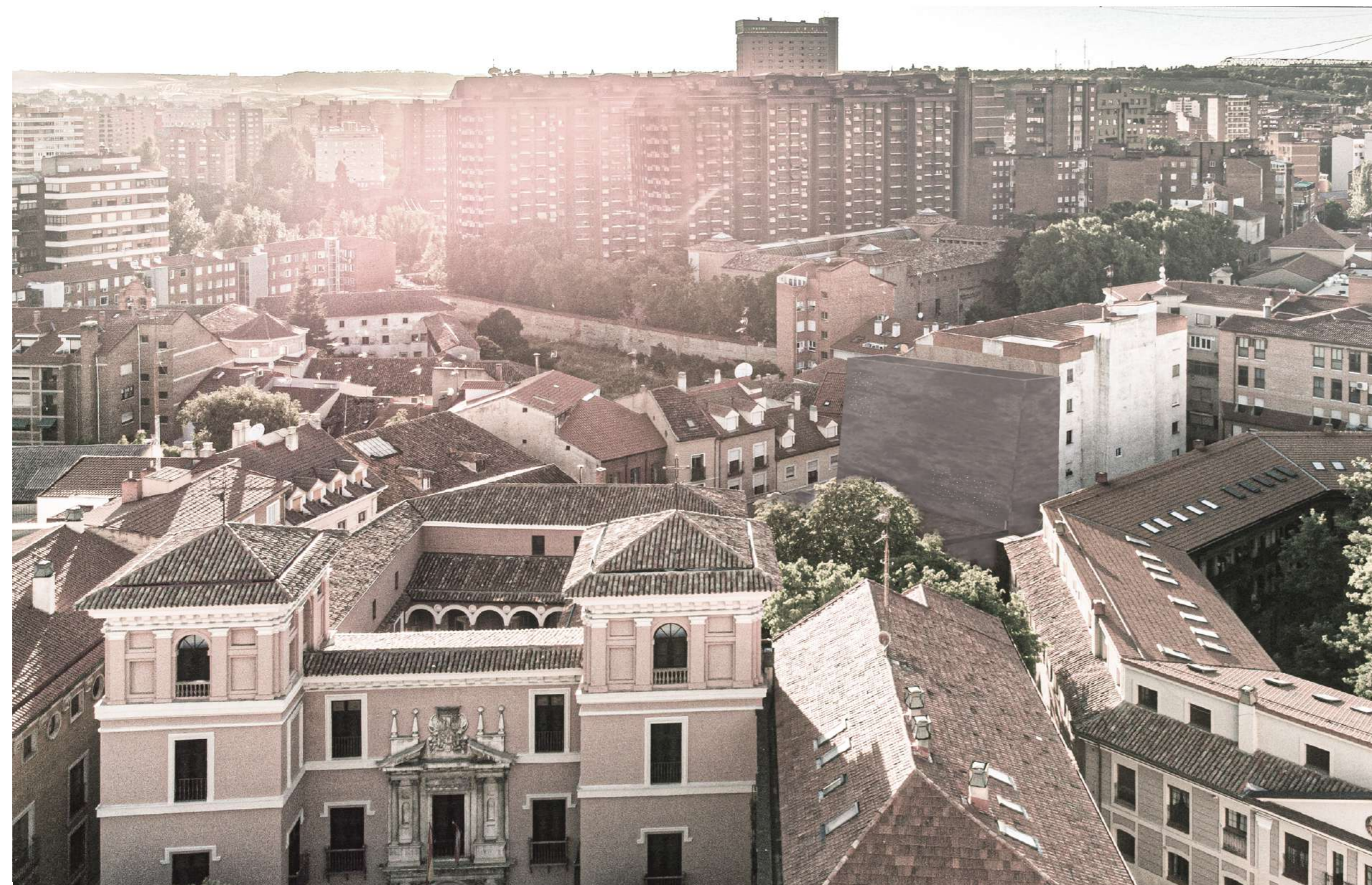
IMAGEN DE SITUACIÓN TRATADA TOMADA CON DRONE
