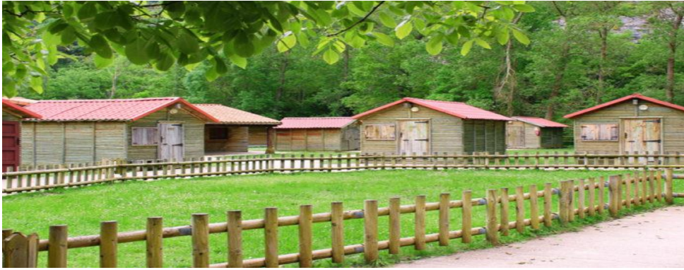
Cabañas exteriores del recinto
