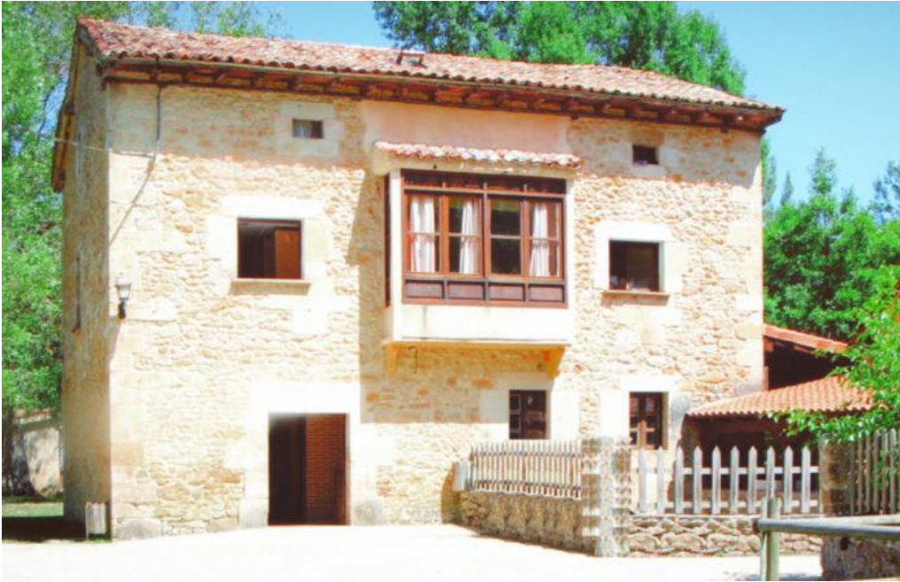
Fachada exterior del Molino
