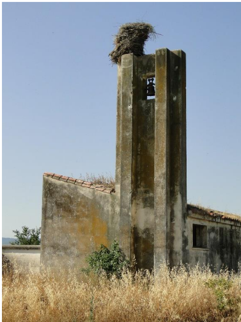
Fig. 2. Cementerio en ruinas de Vegas Altas. Foto: autores
