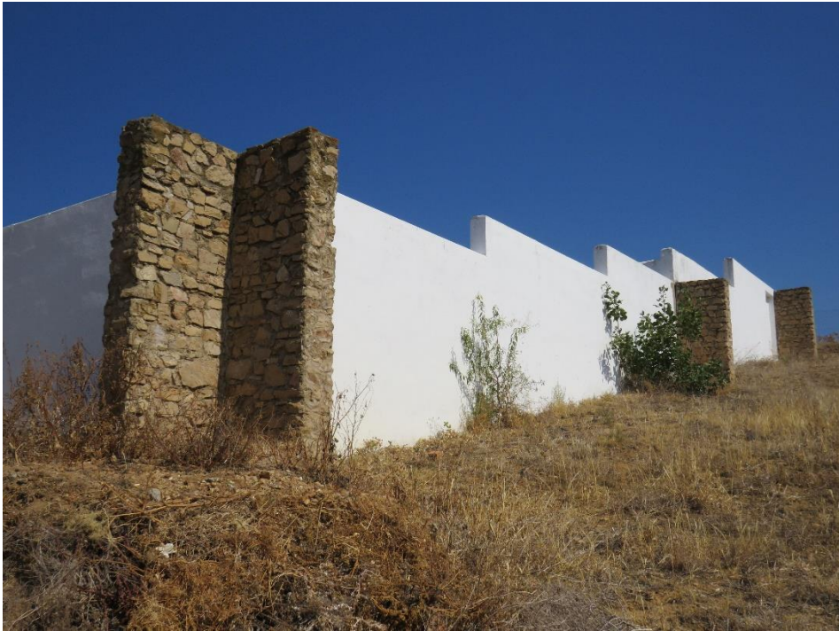
Fig. 4. Cerramiento de Guadajira con los contrafuertes exteriores. Foto: autores
