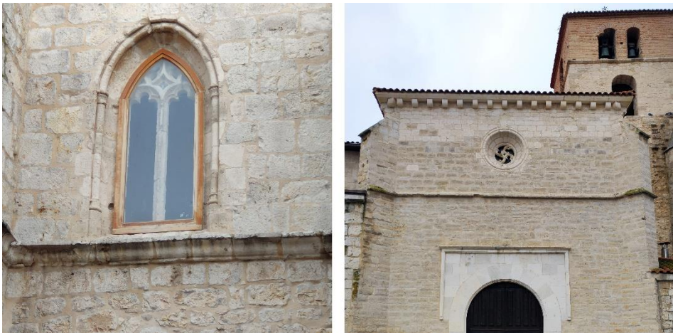
Fig. 2. Iglesia parroquial de Laguna de Duero. Izquierda: ventana del primer tramo. Derecha: cornisa de la cabecera
