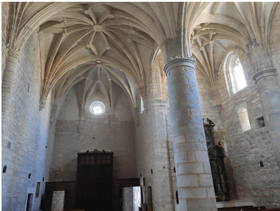
Fig. 3. Iglesia parroquial de Laguna de Duero. Primer tramo de naves
