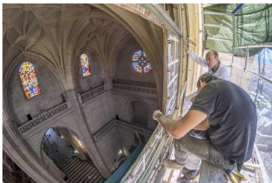
Fig. 6. Los profesionales de Vetraria Muñoz de Pablos trabajan en la restauración de urgencia de la vidriera de La Asunción de la Virgen. Recuperada de: Segoviaudaz.es
