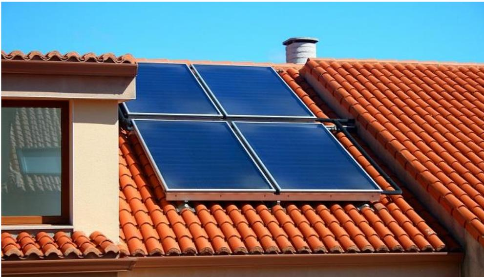
*Figura 5 Panel plano con cubierta. Solución comercial.*
