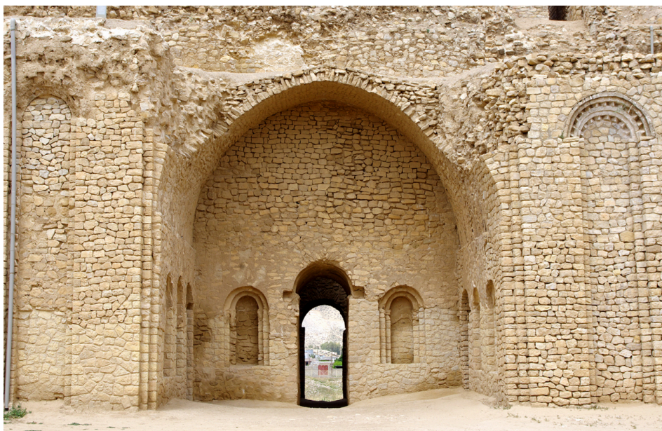
6 – Palacio de Firuzabad, Irán. Patio principal. Los arcos de las hornacinas y los arcos de descarga son de medio punto; el del iwān es medio punto peraltado. Foto del autor.
