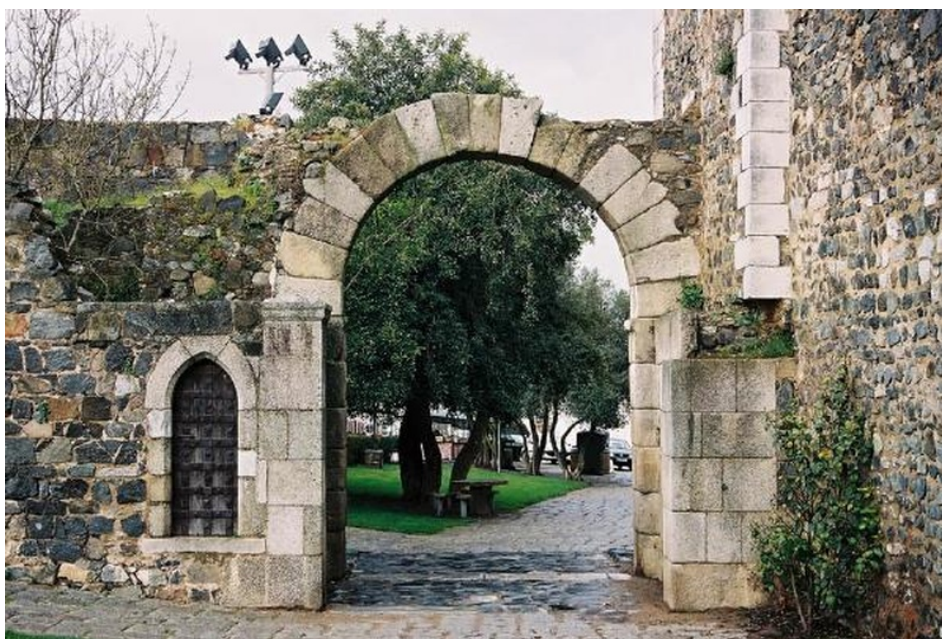
8 – Puerta de Évora en la muralla romana de Beja, Portugal. Foto Direção-Geral do Património Cultural.
