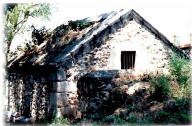
Figura 5. Vista del primer desarenador
