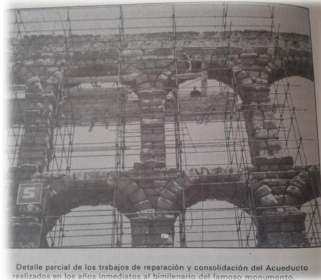
Figura 8. Reparación y consolidación del Acueducto.
