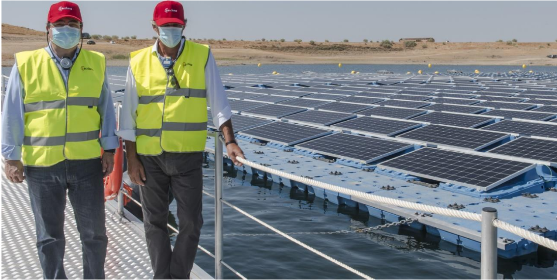
(Placa fotovoltaica flotante de Extremadura, Acciona.com)
