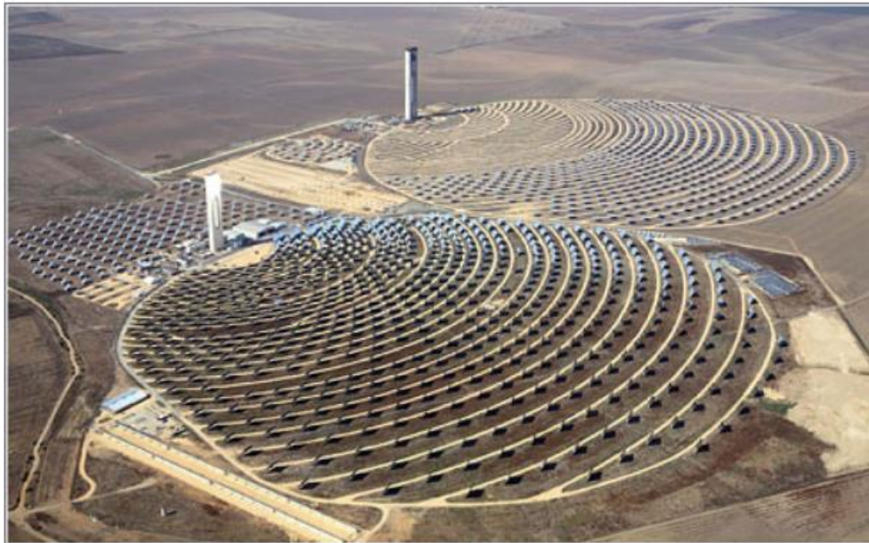
(Centrales térmicas solares PS10 y PS20 en Sevilla, Abengoa Solar)
