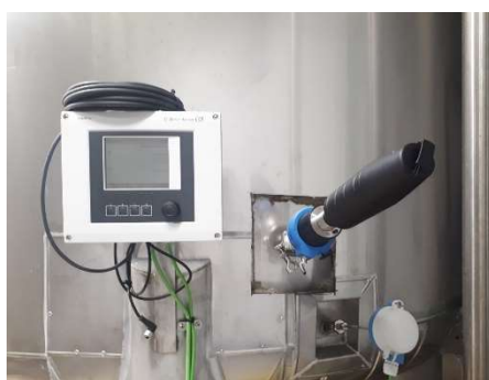
Figura 5. Fotografía de la sonda de pH que han instalado en Lesaffre en la zona de masa madre.
