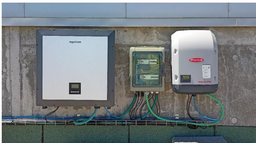
Figura 57: Inversores de la planta fotovoltaica. Fuente: Elaboración propia.
