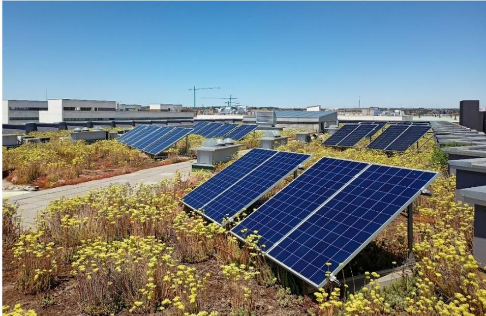
Figura 56: Planta fotovoltaica de la azotea del edificio LUCIA. Fuente: Elaboración propia.
