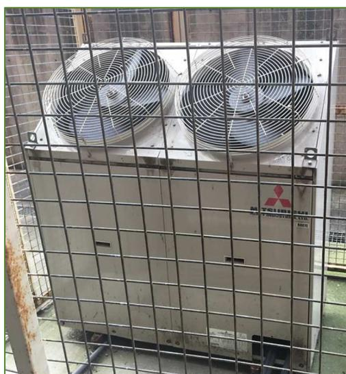
*Ilustración 16. Unidad exterior del sistema de climatización del Aulario Esgueva. Fuente: (López Lorenzo, 2017)*
