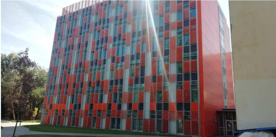
*Ilustración 23. Fachada ventilada IndUVa (Elaboración propia. Octubre 2021)*
