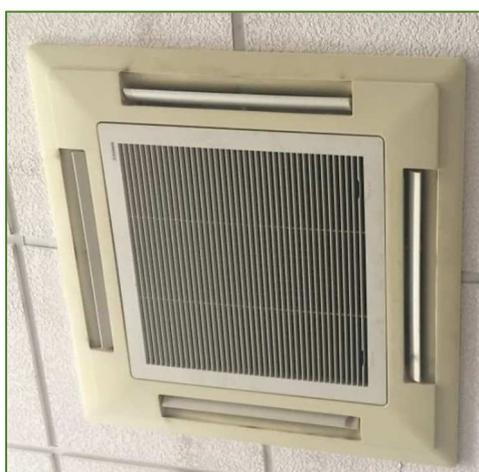
*Ilustración 15. Unidad interior del sistema de climatización del Aulario Esgueva. Fuente: (López Lorenzo, 2017)*
