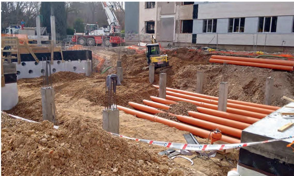
Ilustración 31. Instalación de tubos geotérmicos en el aula IndUVa. Fuente: FACHADFA INTEGRADA FOTOVOLTAICA BIPV.pdf
