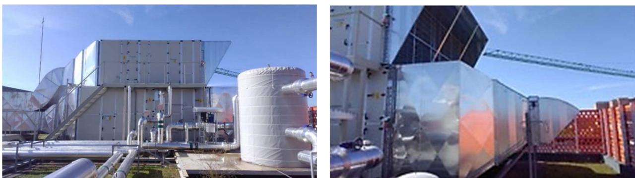
Ilustración 35. Climatizador instalado en servicio en el aula IndUVa. Fuente: Elaboración propia (Noviembre 2021)
