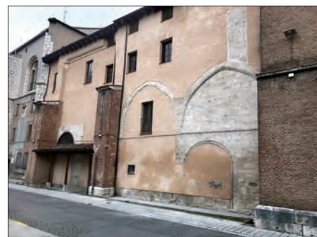
Huellas de la vieja sacristía en el extremo NE del desaparecido claustro
