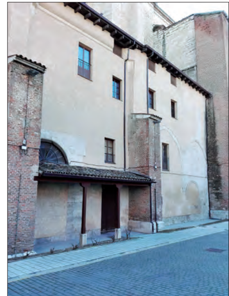
Estado actual del exterior del cuarto del duque
