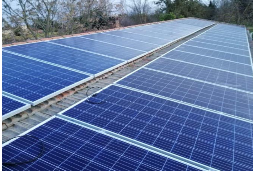
Figura - 2.1- Estructura coplanar
