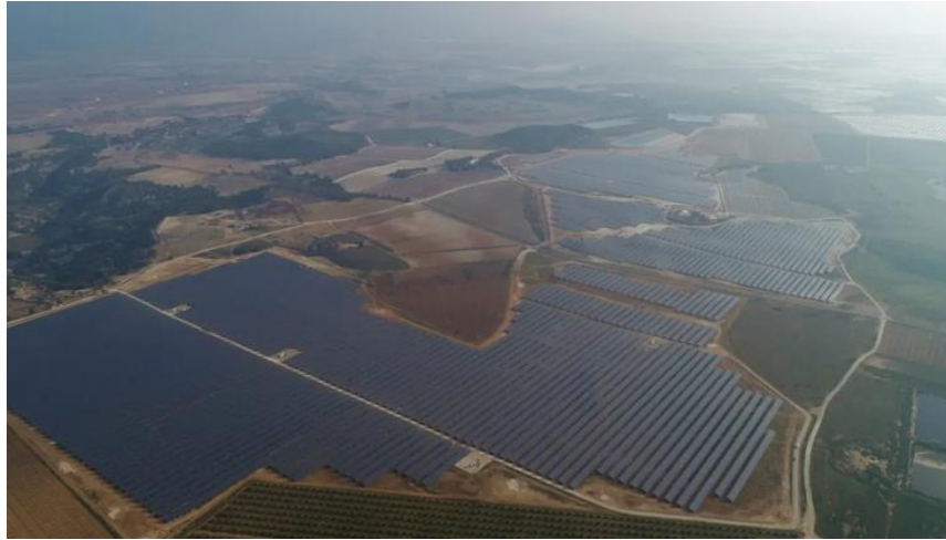
Figura 1.4- Instalación fotovoltaica de producción
