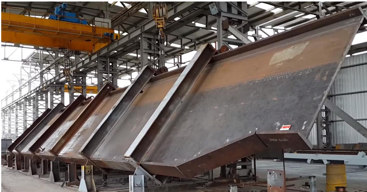
Figura 50 - Fabricación de una viga carrilera
