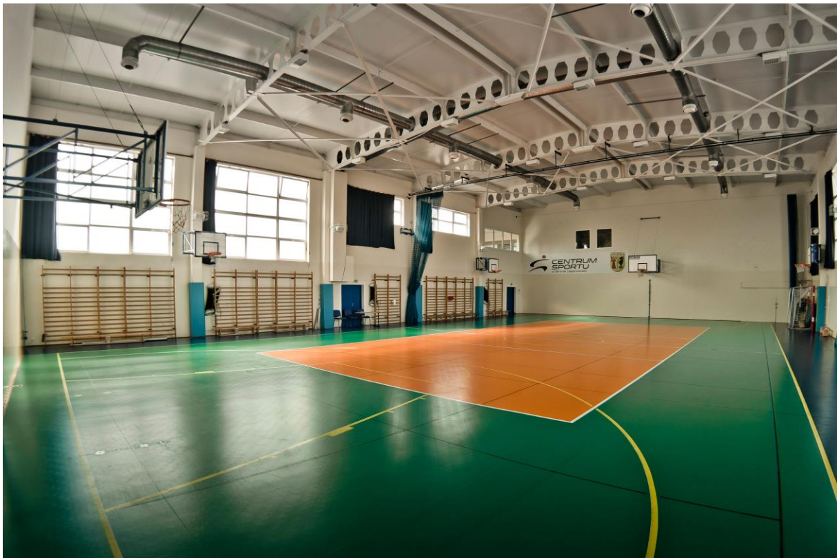
Figura 49 - Estructura polideportivo de viga armada presentando curvatura
