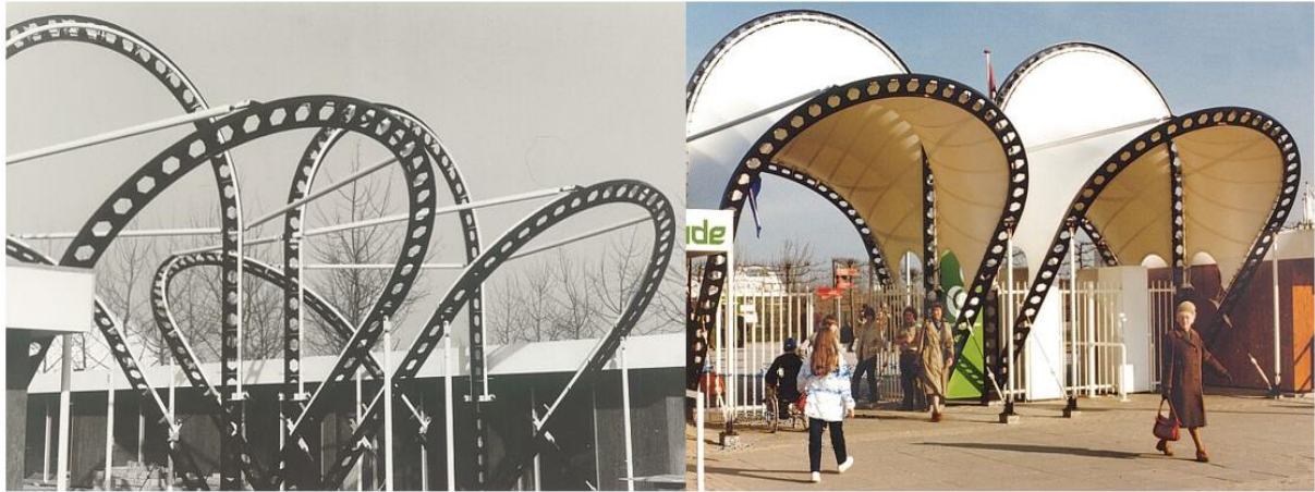
Figura 2 - Puertas entrada a la Expo Mundial 'Floriade' en 1981, Amsterdam. Empleo de vigas fuertemente curvadas alveolares con alveolo hexagonal.
