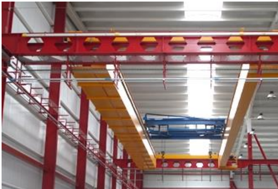
Figura 1 - Vigas alveolares de alveolo hexagonal para carril de puente grúa
