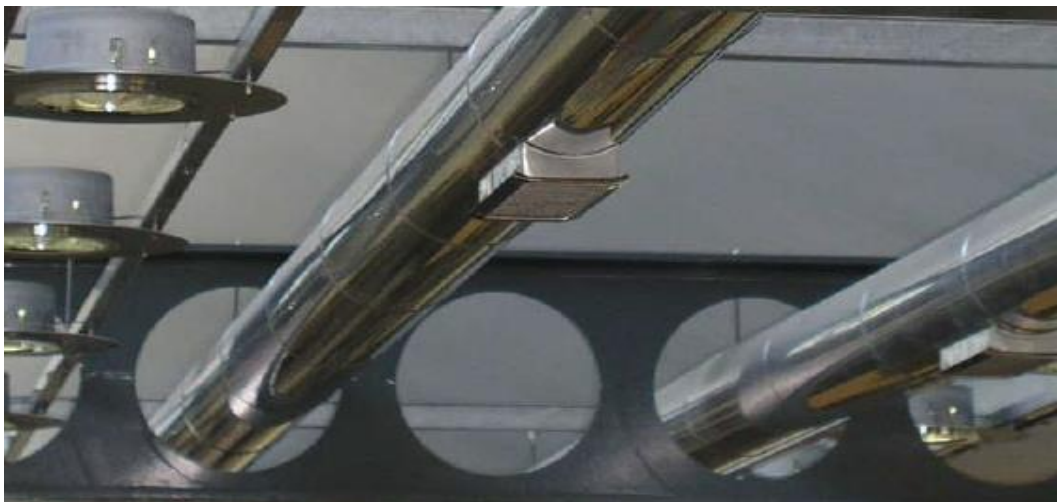
Figura 11 - Viga alveolar facilitando paso de instalaciones
