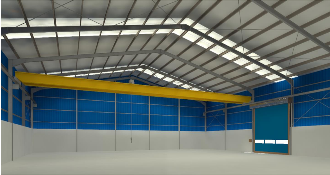
Figura 20 - Zona interior de la nave con el puente grúa
