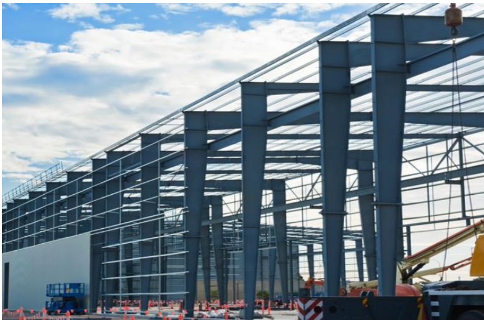
Figura 55 - Pilares pórticos sección variable
