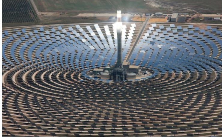
Figura 4. Energía solar térmica [7]
